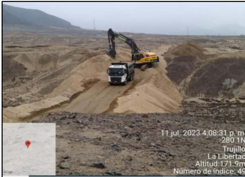
Figura N°9 Carguío y transporte de material excedente
