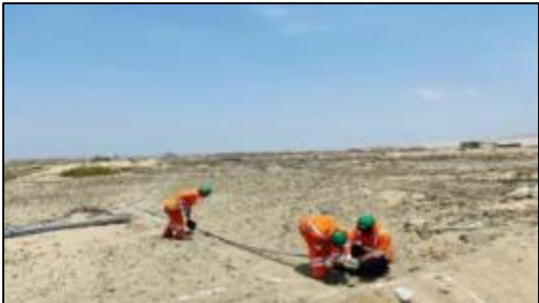
Figura N°52 Reubicación de tubería de PVC 1”
