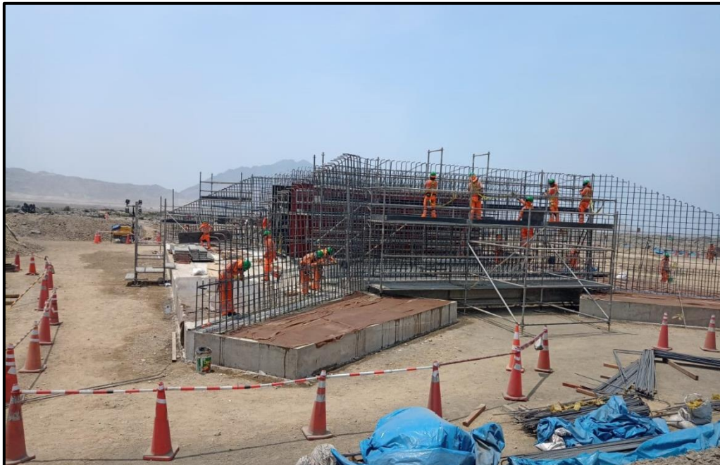
Figura N°30 Colocación de acero en muros de la alcantarilla
