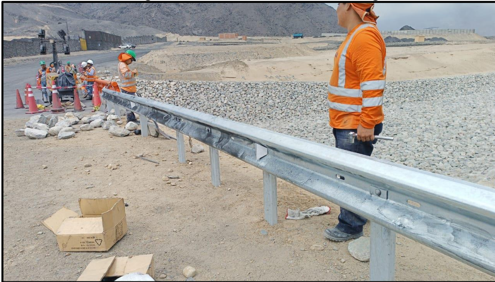
Figura N°36 Colocación de barreras de seguridad
