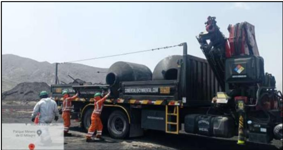
Figura N°38 Retiro de los dos tanques de agua y Esteras
