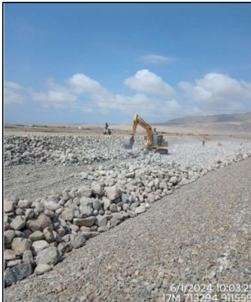
Figura N°18 Colocación de material 4-2 en canal
