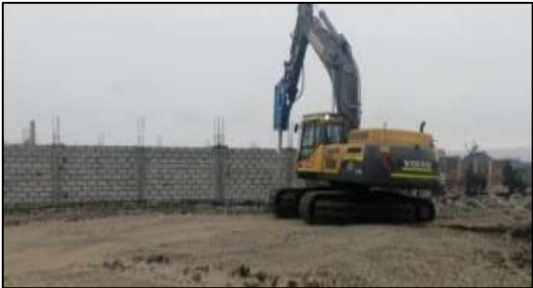
Figura N°50 Demolición de muro de ladrillo
