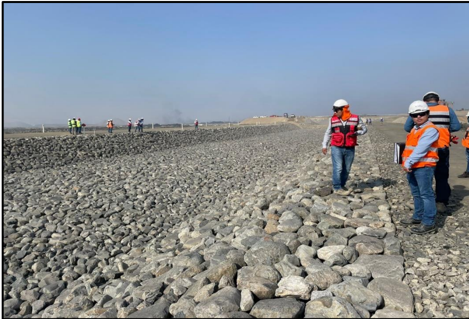
Figura N°60 Recorrido de obra al 100%
