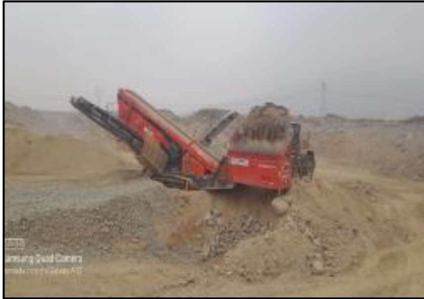
Figura N°14 Producción de material 4A en cantera
