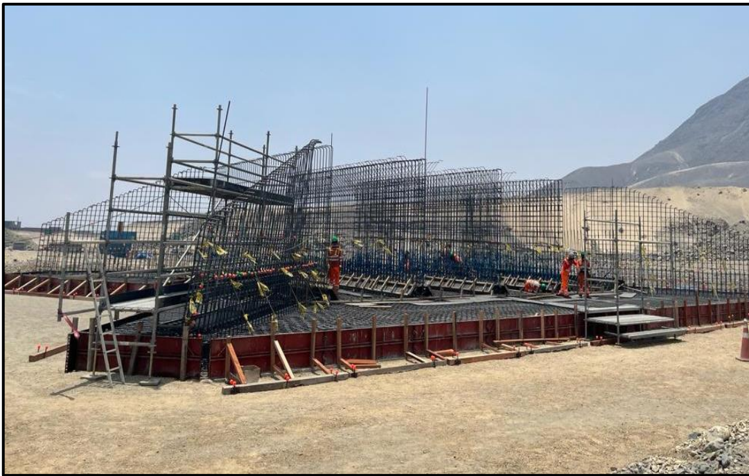
Figura N°24 Encofrado de losa inferior en la alcantarilla
