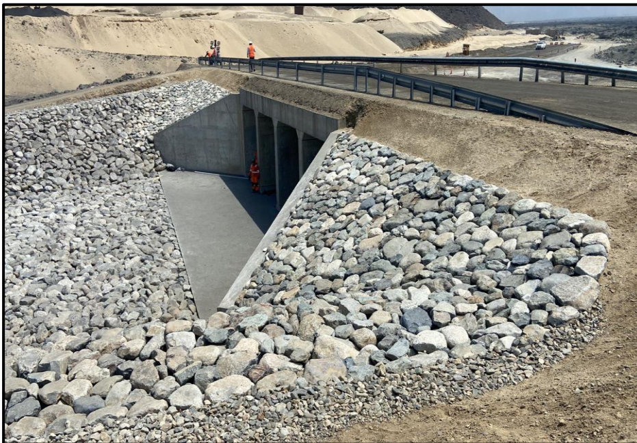
Figura N°57 Recepción de alcantarilla el milagro
