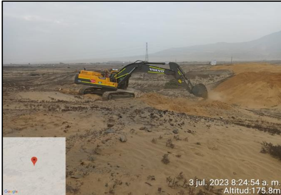
Figura N°7 Excavación de material no clasificado en el canal
