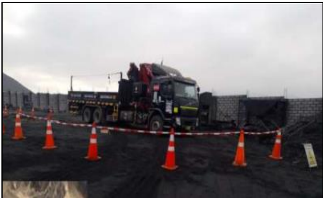
Figura N°41 Desmontaje y reubicación de zaranda chancadora
