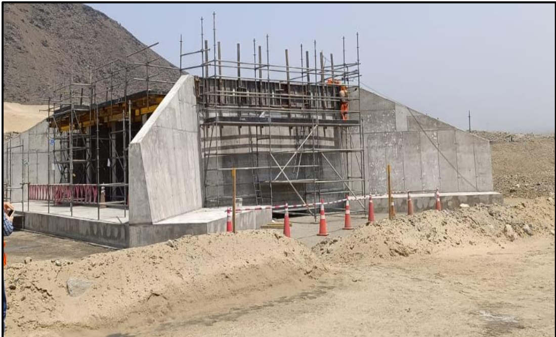
Figura N°27 Encofrado de losa superior
