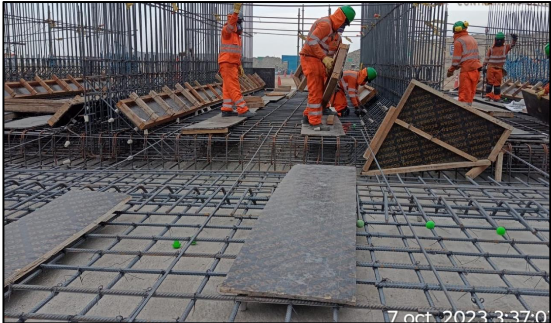
Figura N°25 Encofrado de ochavos
