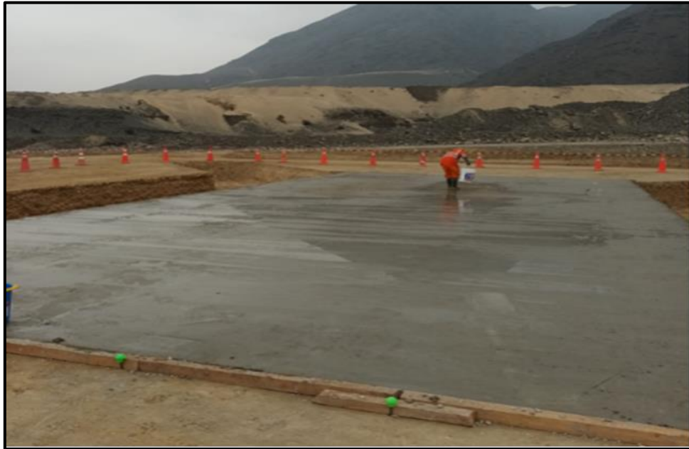
Figura N°32 Colocación concreto premezclado fc' 100 \text{ kg/cm}^2 en solado
