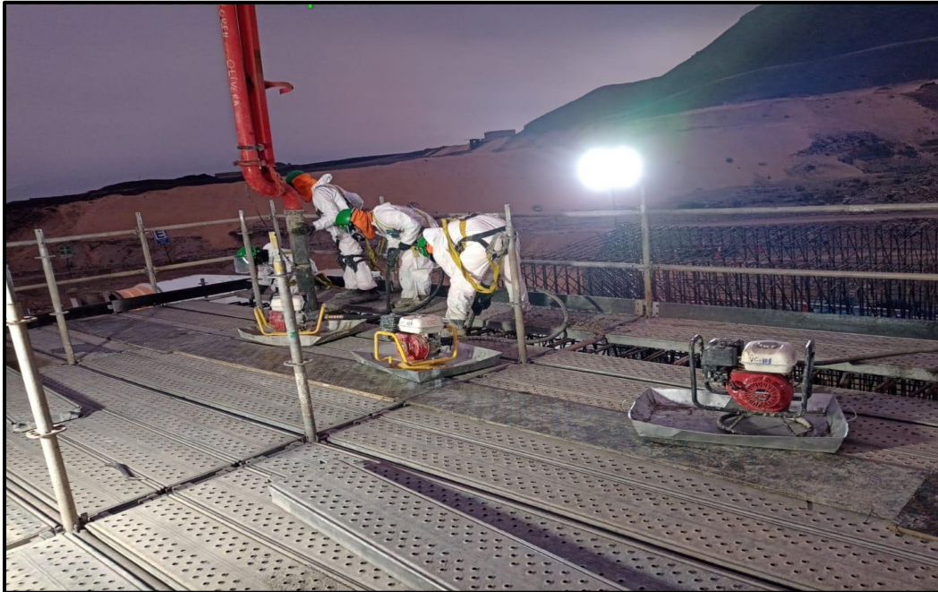
Figura N°34 Colocación de concreto premezclado fc' 280 \text{ kg/cm}^2 en muros de la alcantarilla
