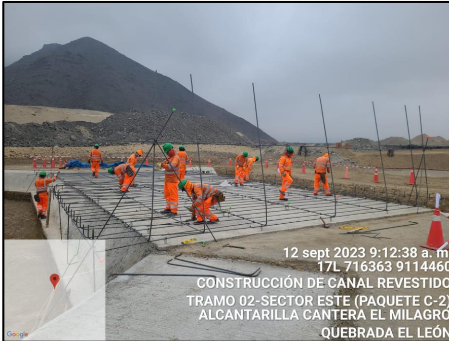
Figura N°29 Colocación de acero en losa inferior de alcantarilla
