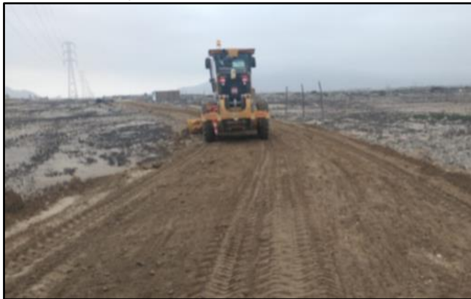
Figura N°8 Mantenimiento de tránsito
