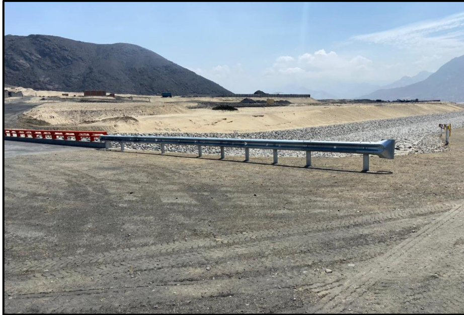
Figura N°58 Barreras de seguridad PK 12+400
