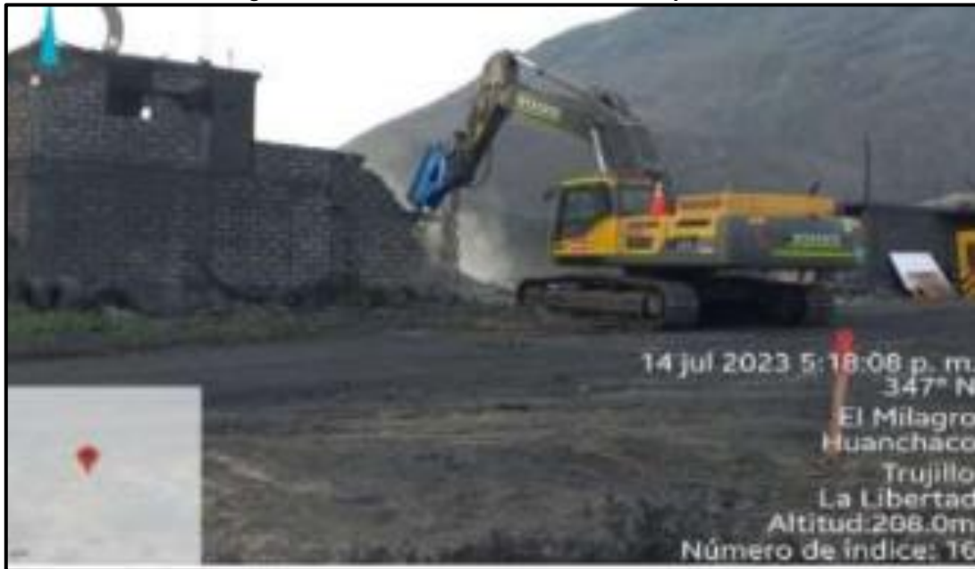
Figura N°44 Demolición de vivienda desocupada
