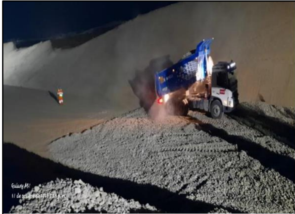
Figura N°16 Descarga de material zona 4A del colchón del canal
