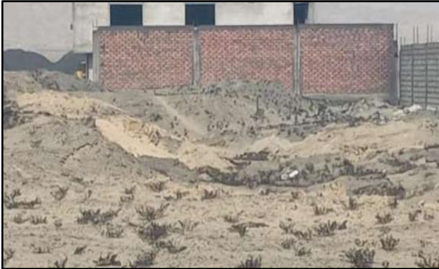
Figura N°46 Muro de ladrillo para demoler
