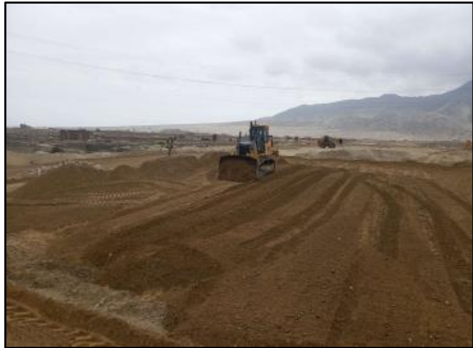
Figura N°13 Conformación de relleno de material Z2 en canal
