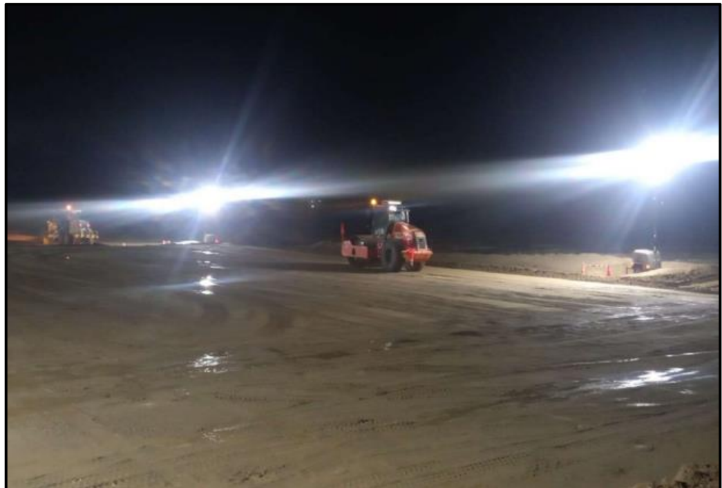
Figura N°12 Compactación de relleno de material Z2 en canal
