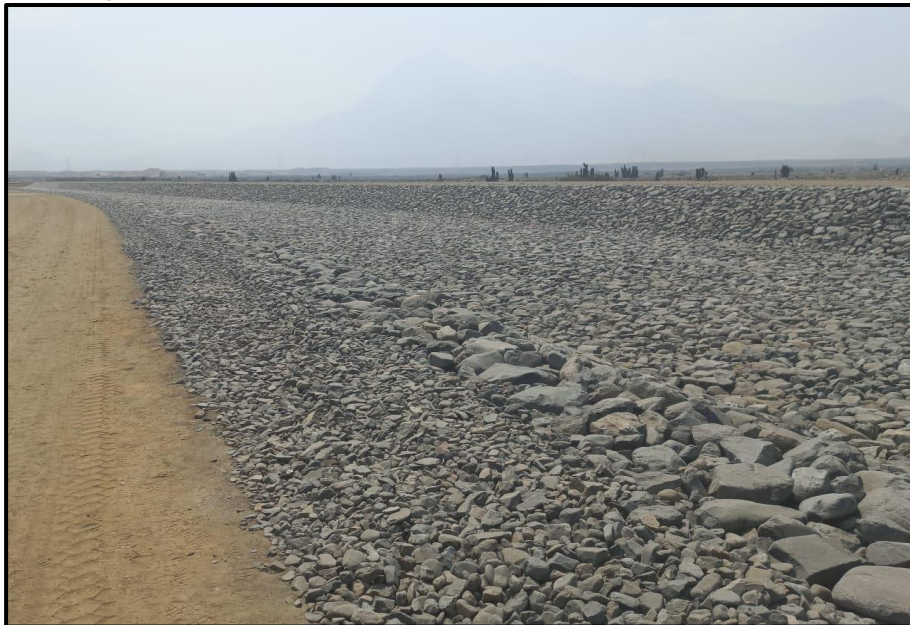
Figura N°59 Canal revestido culminado de la PK 13+000 @ 13+900
