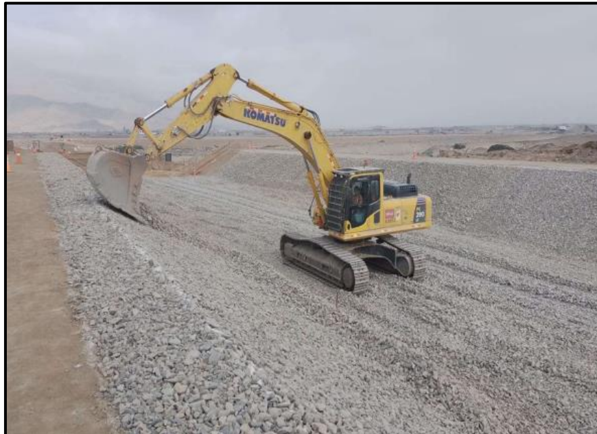
Figura N°15 Colocación de material zona 4A en talud del canal
