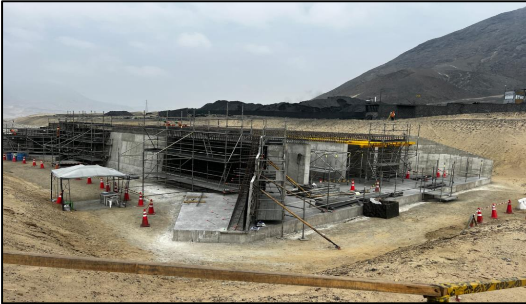
Figura N°31 Colocación de acero en losa superior de la alcantarilla
