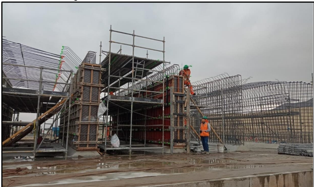
Figura N°26 Encofrado de muros de la alcantarilla
