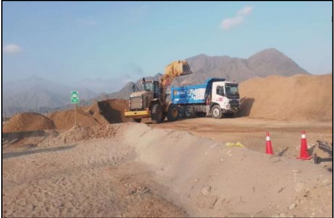
Figura N°11 Carguío de material Z2
