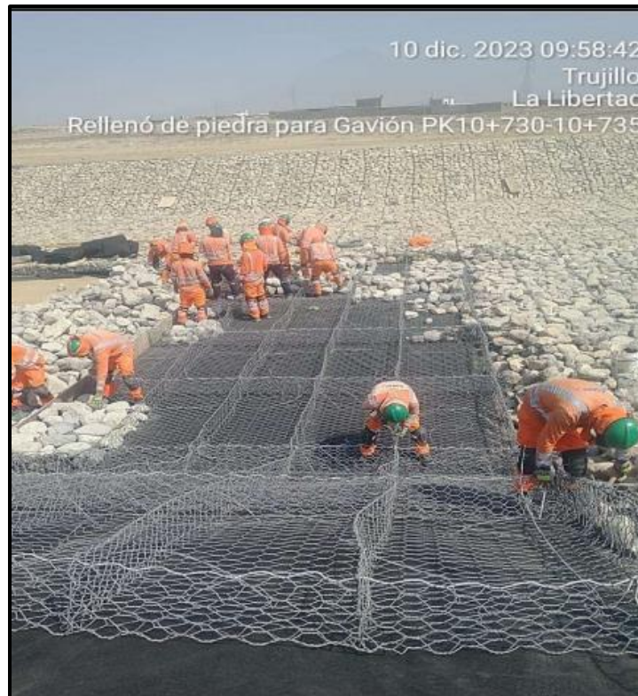
Figura N°21 Colocación de gaviones tipo colchón
