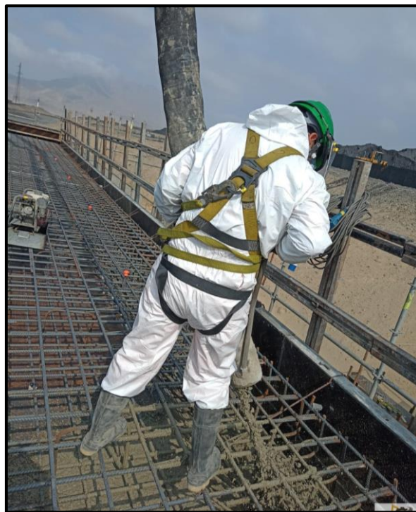
Figura N°35 Colocación de concreto premezclado fc' 280 \text{ kg/cm}^2 en losa superior
