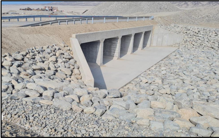
Figura N°56 Alcantarilla el milagro al 95%
