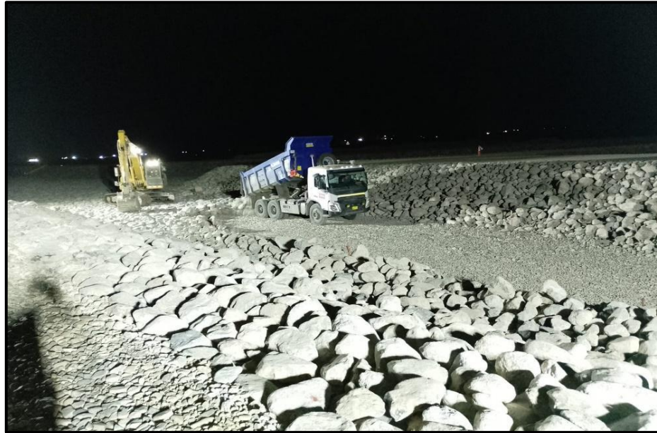
Figura N°19 Descarga de material zona 4-2
