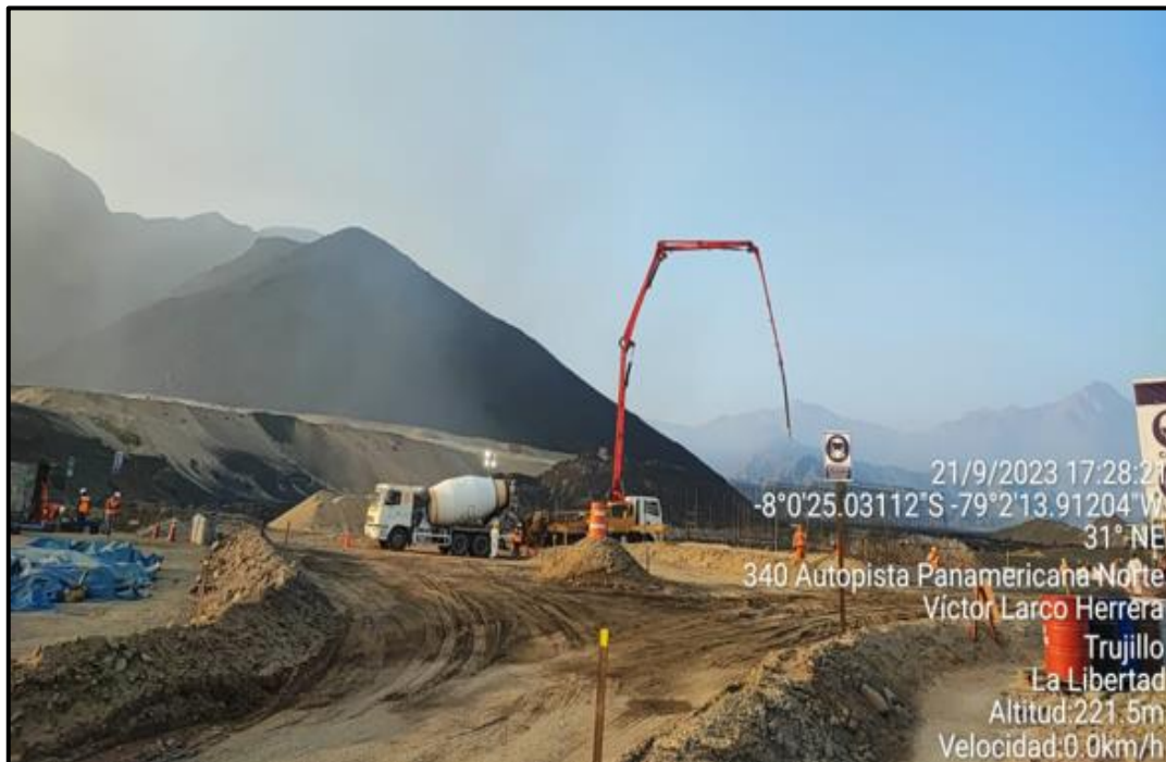
Figura N°33 Colocación de concreto premezclado fc' 280 \text{ kg/cm}^2 en losa inferior
