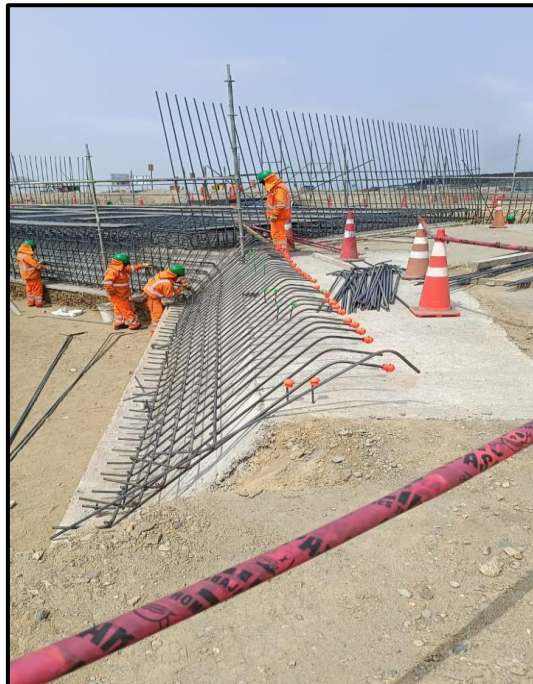
Figura N°28 Colocación de acero en llaves de corte
