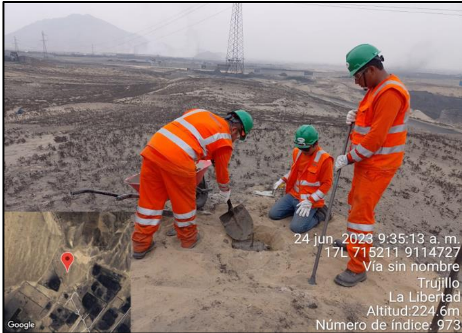
Figura N°6 Construcción de hitos
