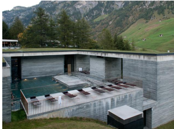
Imagen N°21 : Vista exterior de centro termo vals.
