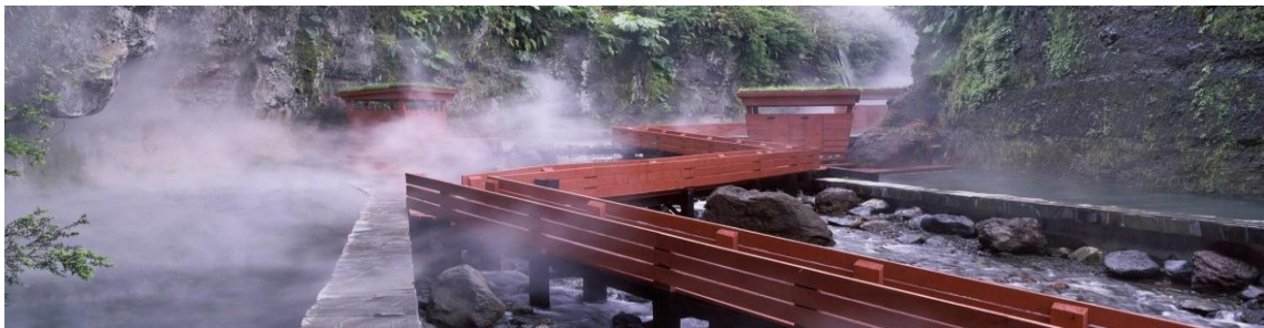
Imagen N°17 : Vista 2 de Puente de aguas termales geotérmicas.
