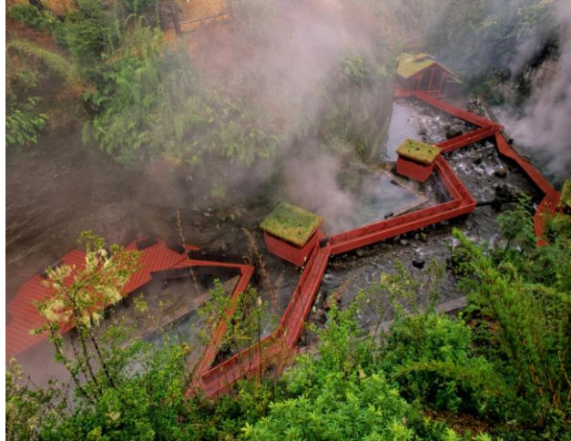
Imagen N°16 : Puente de aguas termales geotérmicas.
