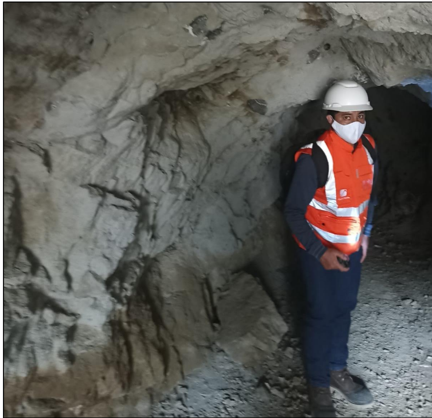
Figura 1. Ingreso a la labor subterránea de estudio.
