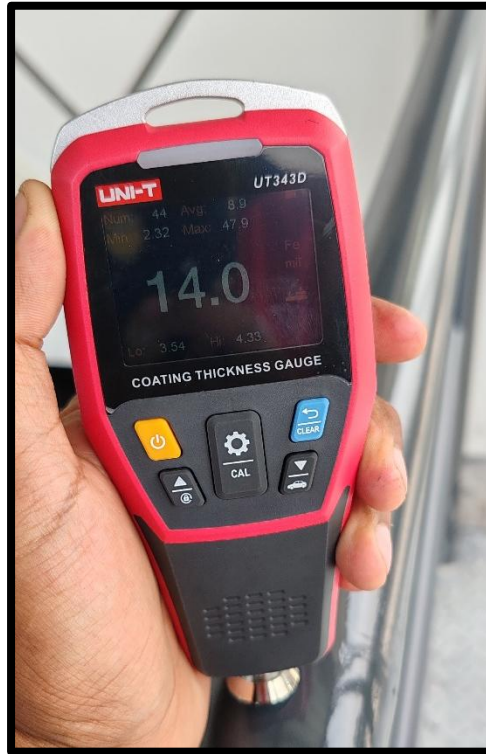
Figura N°15 Medición de pintura con medidor de espesores, se observa 14mils, el mínimo que nos pide el cliente es 8mils.
