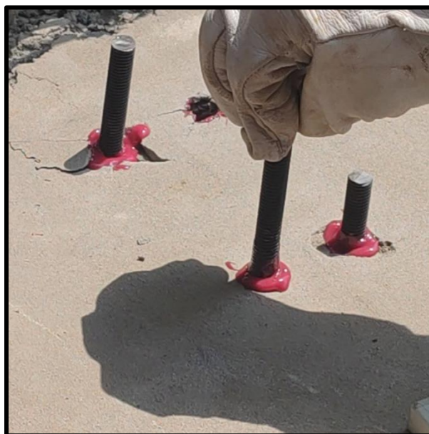
Figura N°30 Colocación de anclajes del cerco TIPO 7.
