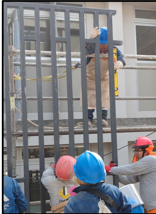
Figura N°21 verificación de niveles del cerco metálico TIPO 1.
