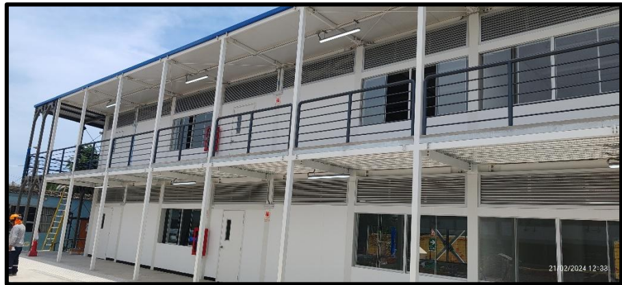
Figura N°13 Pintado de elementos metálicos.
