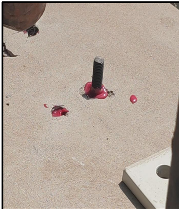
Figura N°24 Instalación del anclaje.
