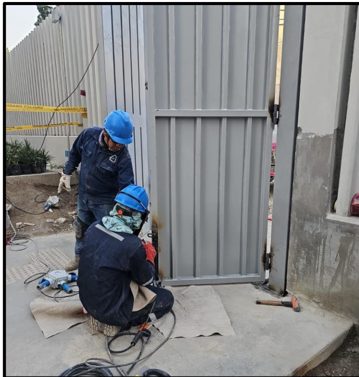
Figura N°12 Procedimiento de instalación de portón metálico.
