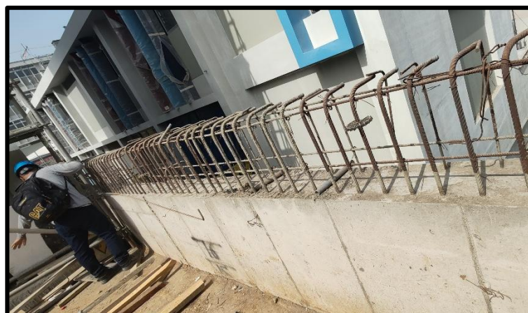
Figura N°17 Remetrado de cercos metálicos.
