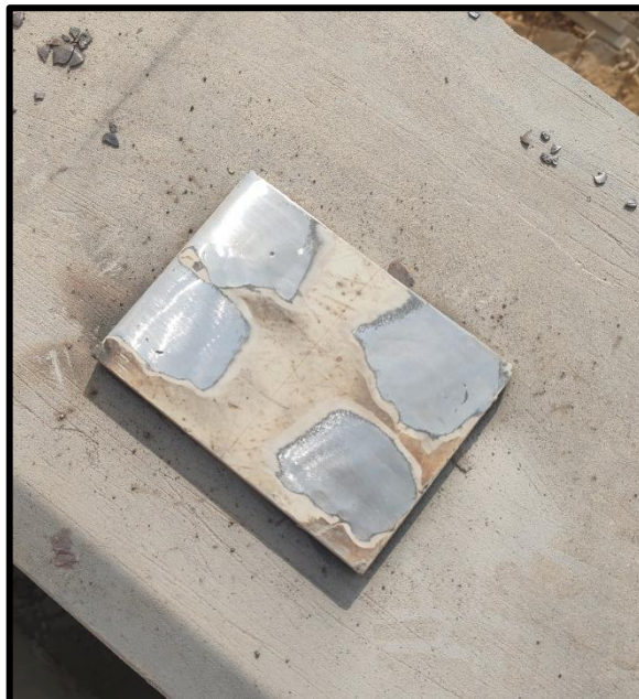
Figura N°11 Procedimiento de soldadura tapón.
