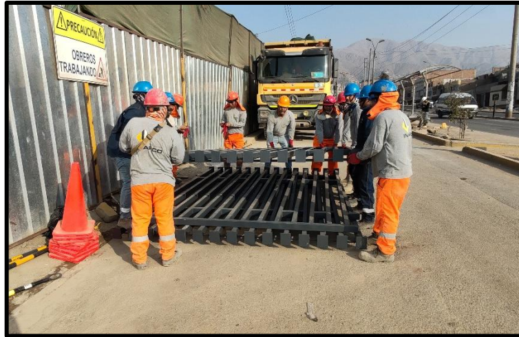
Figura N°16 movilización de equipos y herramientas.
