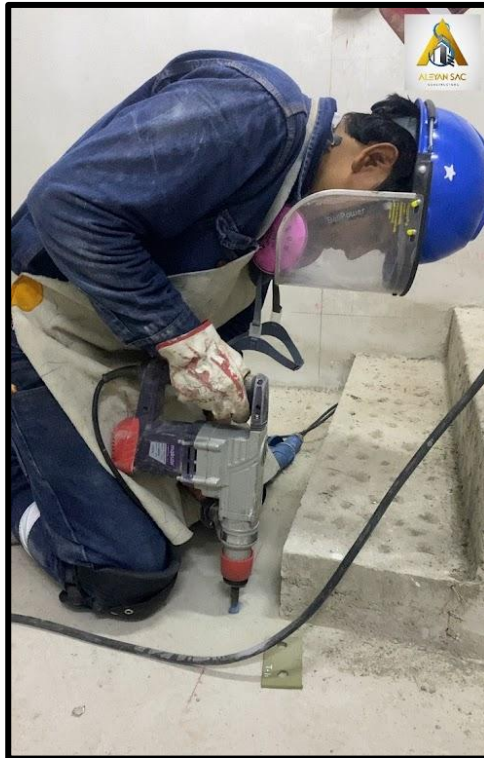
Figura N°7 Instalación de las barandas metálicas (EEMM).
