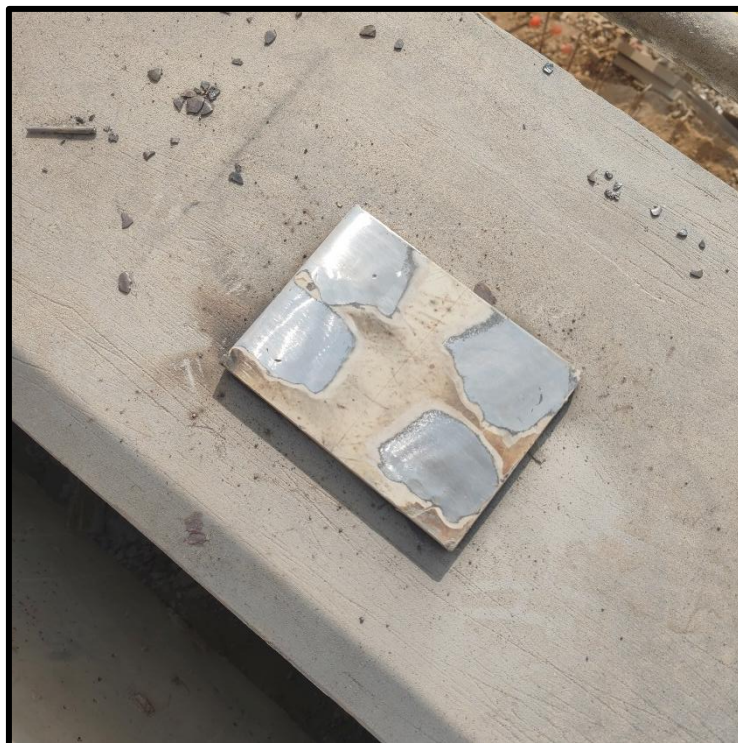
Figura N°33 Limpieza metálica de plancha metálica del cerco TIPO 7.
