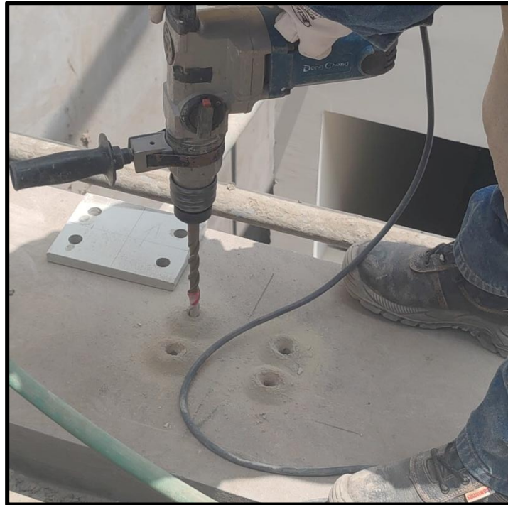
Figura N°29 Perforación de anclaje del cerco TIPO 7.
