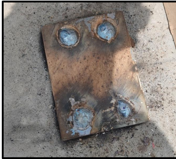
Figura N°32 Soldadura tapón cerco TIPO 7.
