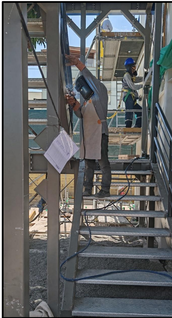
Figura N°8 Instalación de las barandas metálicas (EEMM).
