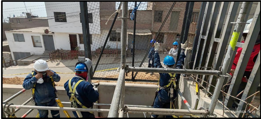
Figura N°26 Instalación de cerco TIPO 4.
