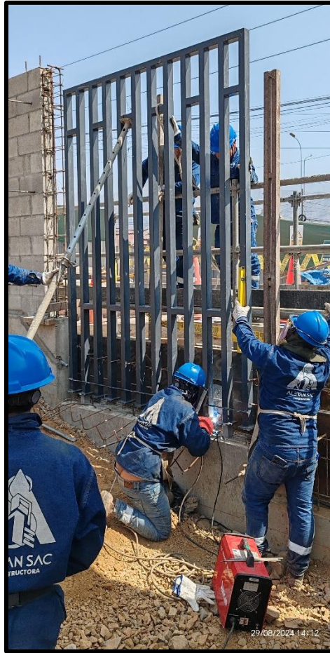
Figura N°19 Instalación de cerco metálico TIPO 1.
