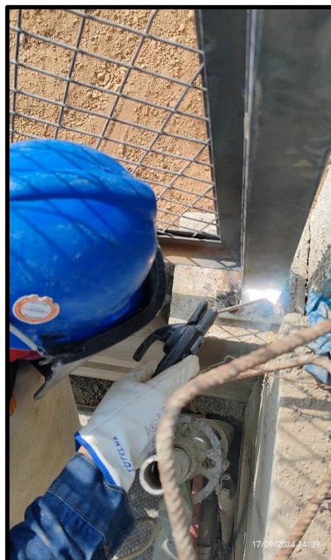
Figura N°27 Proceso de soldadura de cerco TIPO 4.
