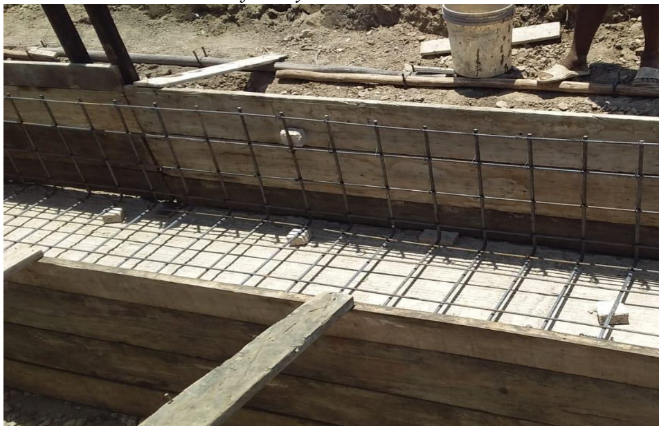
Figura 33 Encofrado y armadura de acero
