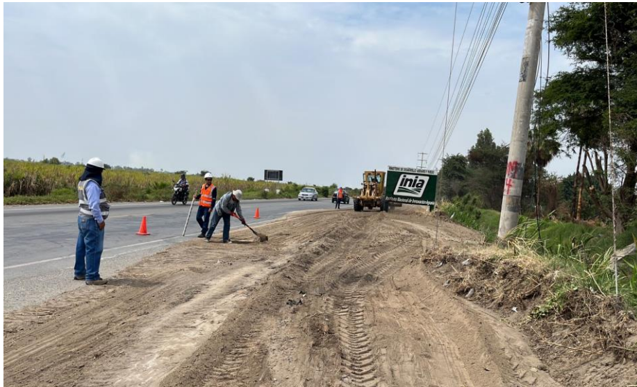
Figura 25 Corte de material orgánico en Canal JARRIN
