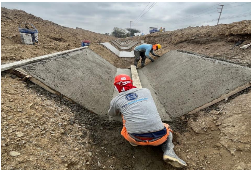
Figura 40 Revestimiento
