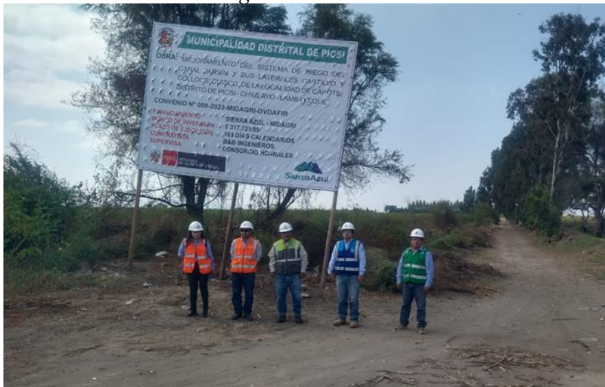
Figura 20 Segundo Cartel de Obra
