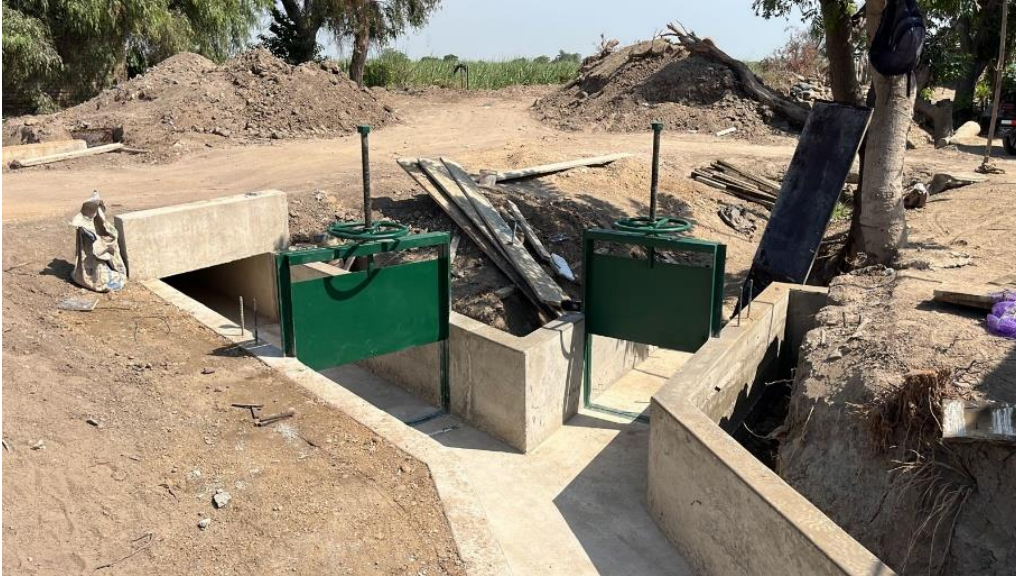
Figura 34 Colocación de compuertas en progresiva
