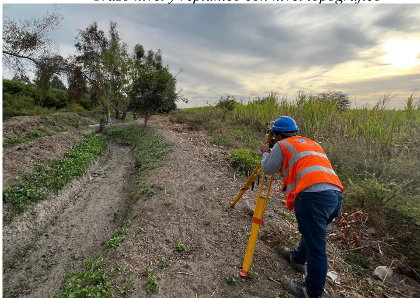
Figura 21 Trazo nivel y replanteo con nivel topográfico
