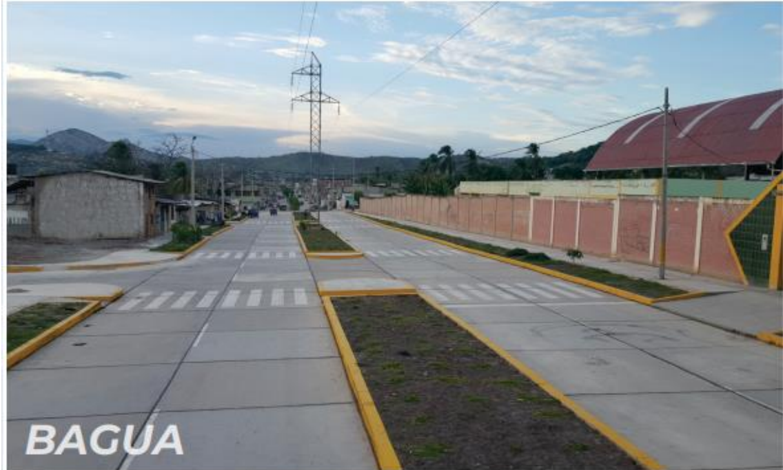
Figura 7 Municipalidad Distrital de Bagua
