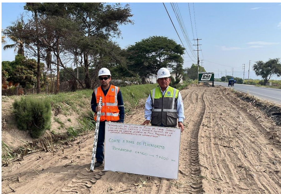
Figura 24 Nivelación Canal JARRIN
