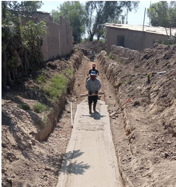
Figura 32 Colocación de solado
