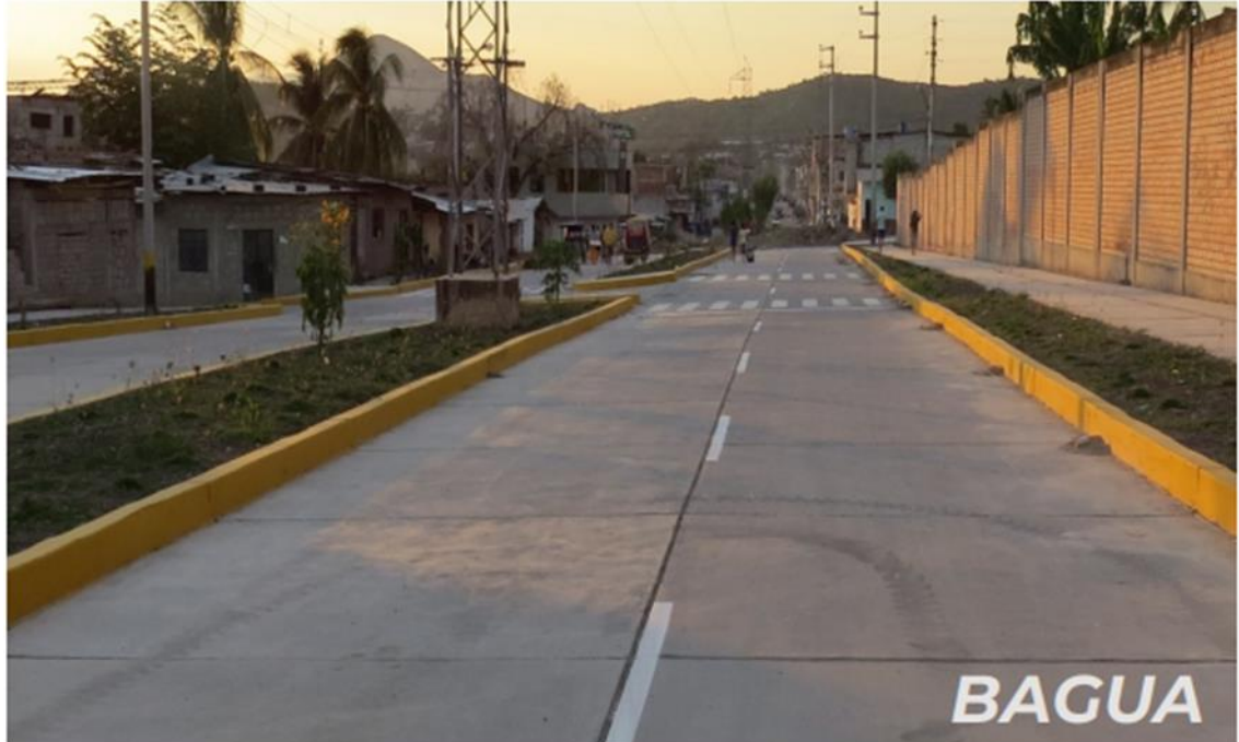
Figura 6 Municipalidad Distrital de Bagua
