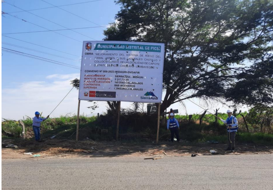
Figura 19 Primer Cartel de obra.
