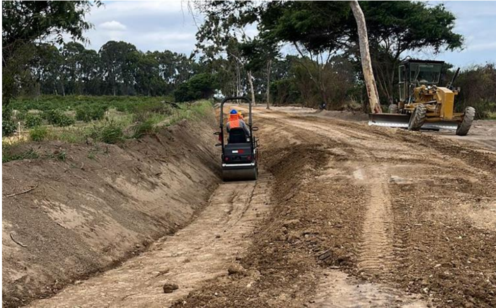
Figura 30 Proceso de compactación
