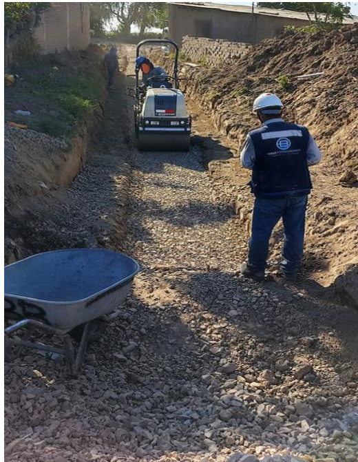
Figura 31 Colocación de Over
