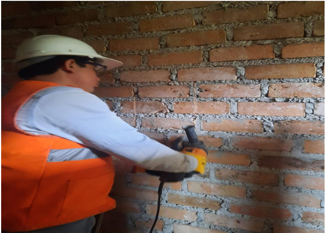
Foto 10. Inicio para corte de ladrillos
