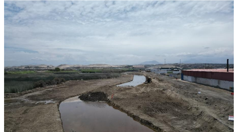
Vista aérea del proyecto
