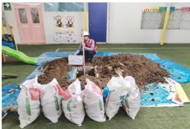
Vista Panorámica de la calicata C-6
