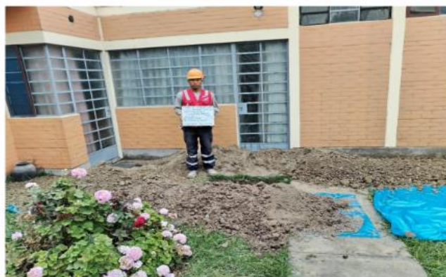
Vista Panorámica de la calicata C-3
