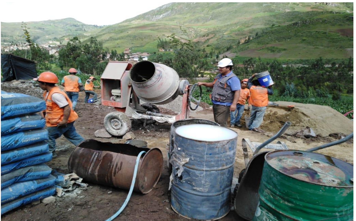
Verificando los tiempos de concreto de obra
