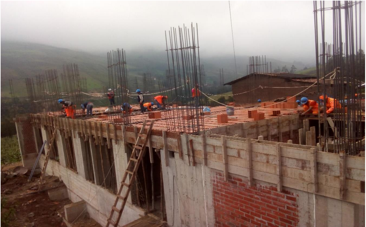
Partida de Estructura – Obras de Concreto Simple – Losa Aligerada
