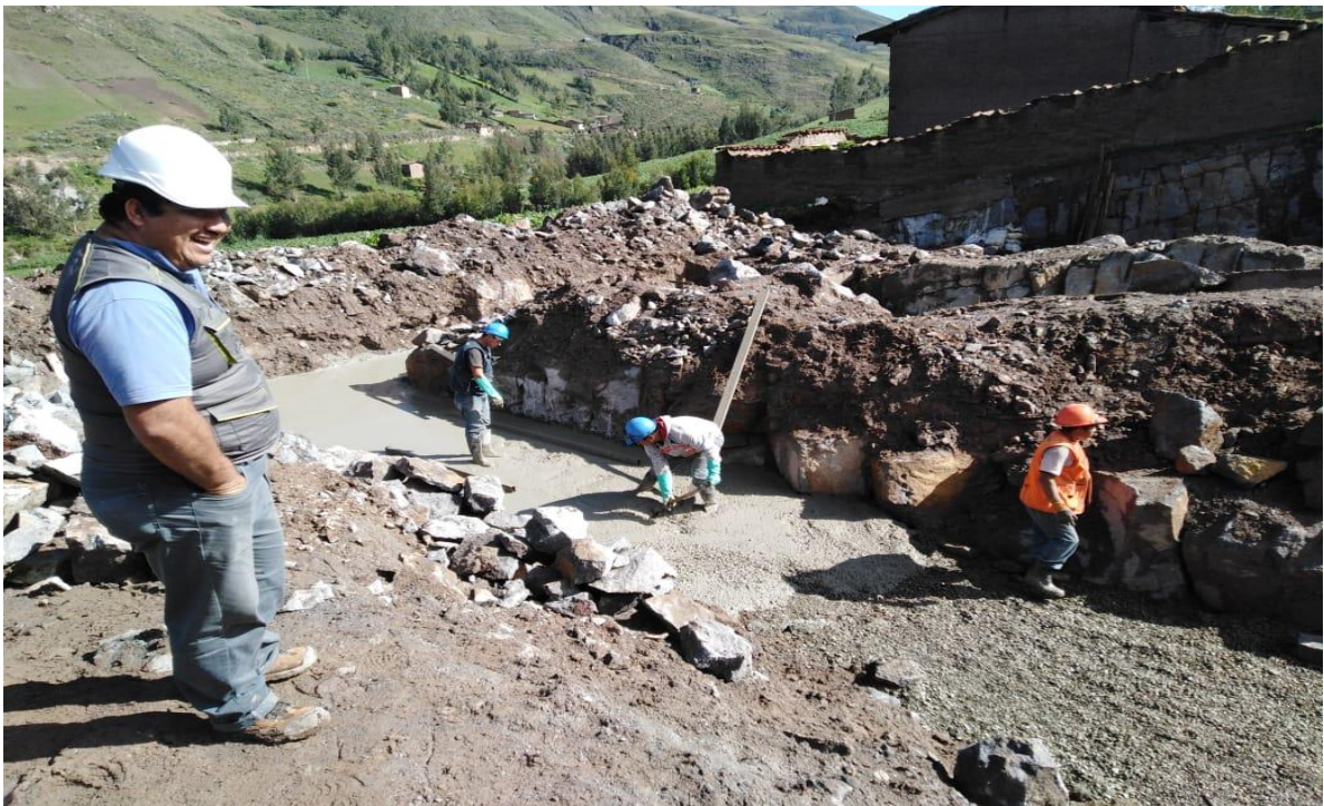
Supervisando la productividad en la partida de cimentación
