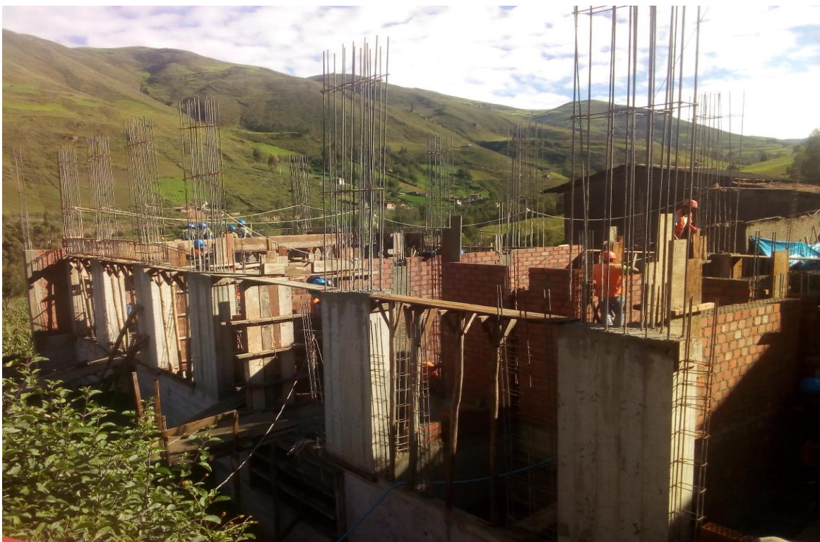
Partida de Estructura – Obras de Concreto Simple - Columnas
