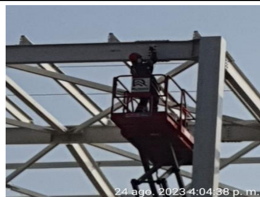
FOTO N°12. TOQUEO DE VIGAS
