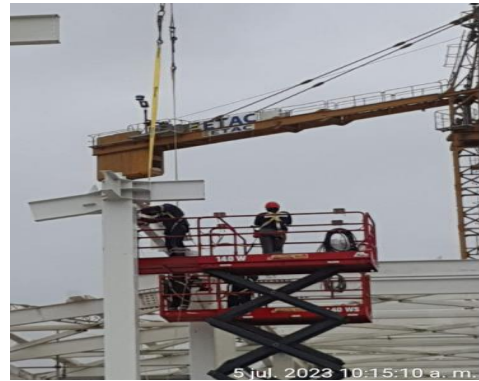
FOTO N°6. MONTAJE DE COLUMNA CENTRAL
