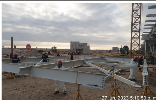
FOTO N°11. ARMADO DE EEMM MODULARMENTE
