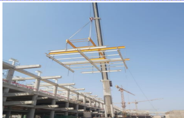
FOTO N°9. MONTAJE DE EEMM CON YUGO DE IZAJE
