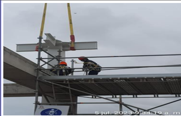
FOTO N°5. MONTAJE DE COLUMNA LATERAL
