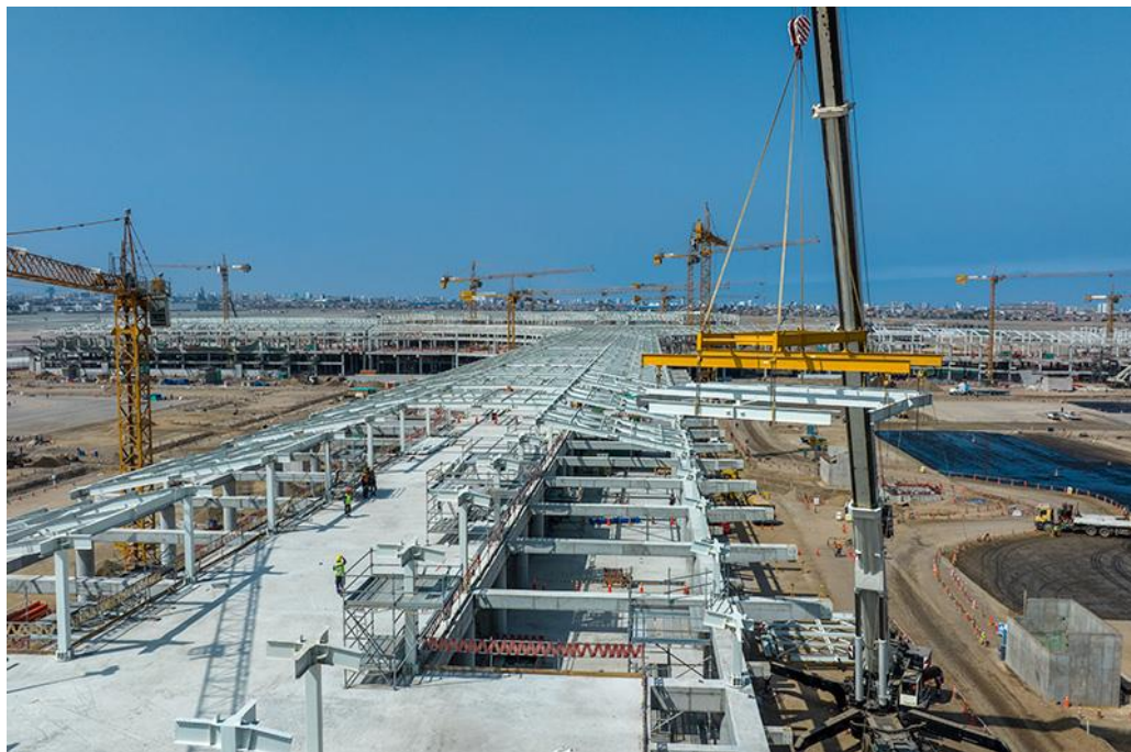
Montaje de estructuras metálicas
