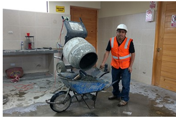
Fotografía N° 20. Acarreo del concreto
