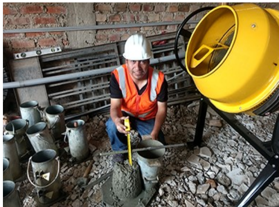
Fotografía N° 25. Midiendo el asentamiento del concreto fresco.
