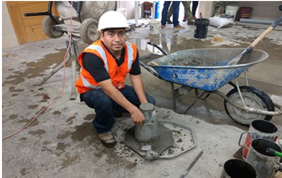
Fotografía N° 17. Midiendo el asentamiento del concreto fresco del agregado de cantera de río.
