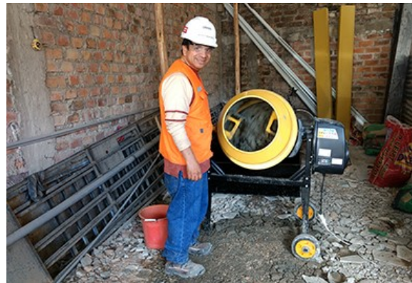
Fotografía N° 24. Mezclado de concreto para la elaboración de probetas
