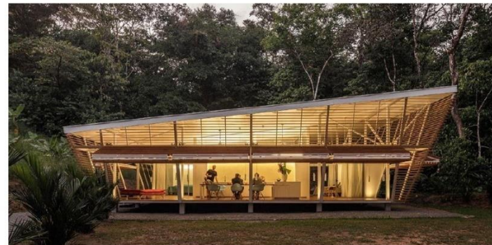
Fuente: Elementos para diseñar una buena iluminación en un hospital
