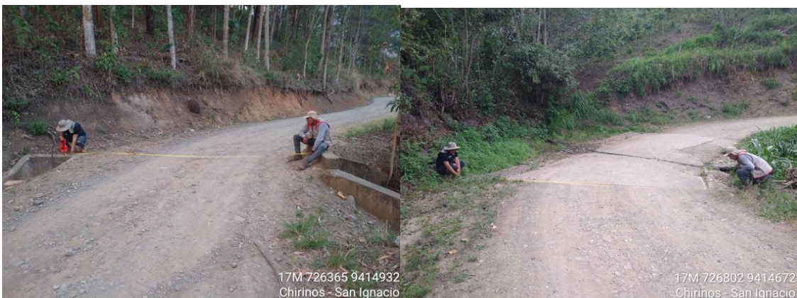
Trabajos de campo del inventario vial de las estructuras existentes.
