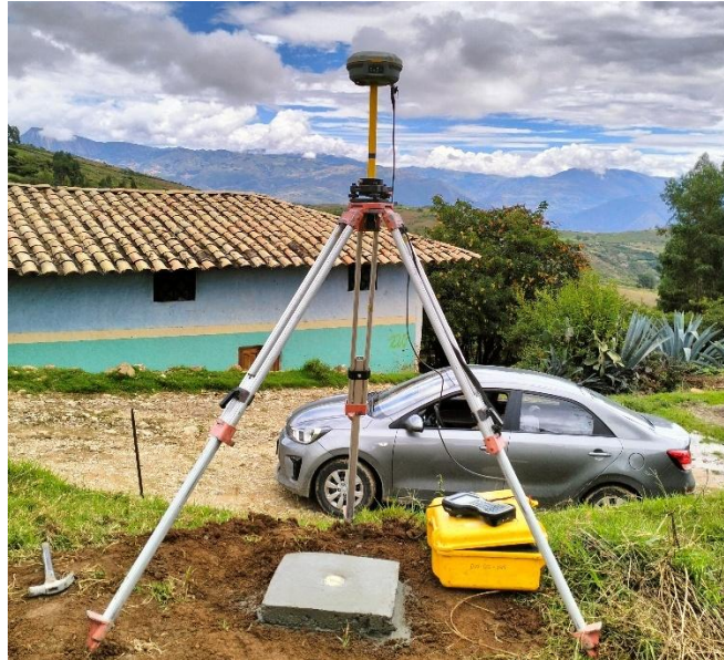
Figura 8: Monumentación de punto Geodésico
