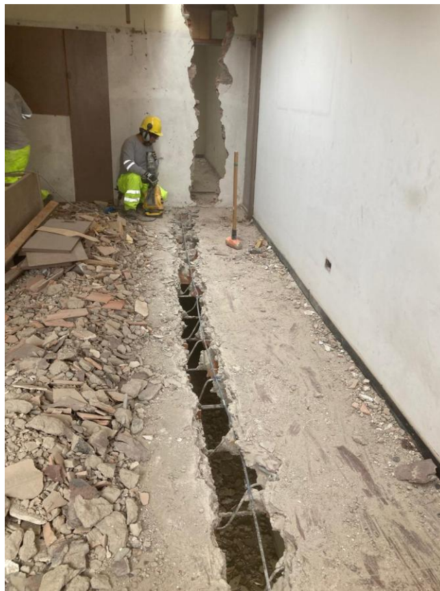
Figura 14. Corte y picado manual
