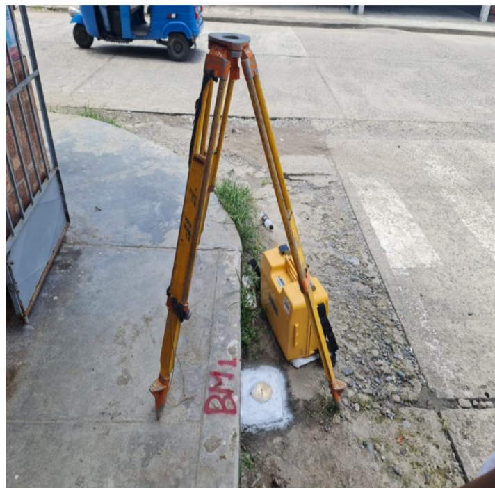
Figura 33. Colocación de BM
