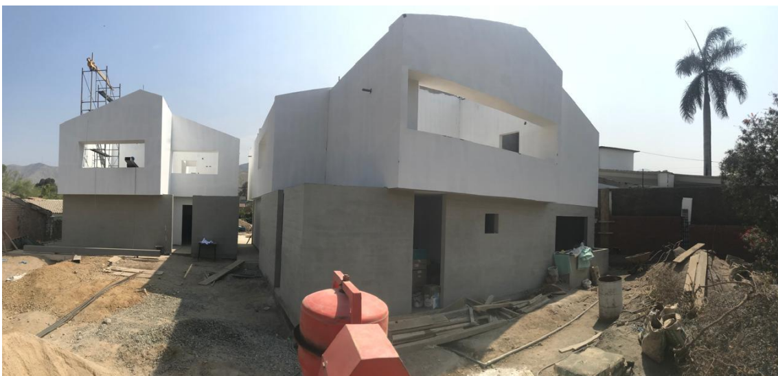
Figura 9. Fachada posterior de viviendas en Country Club La Planicie.
