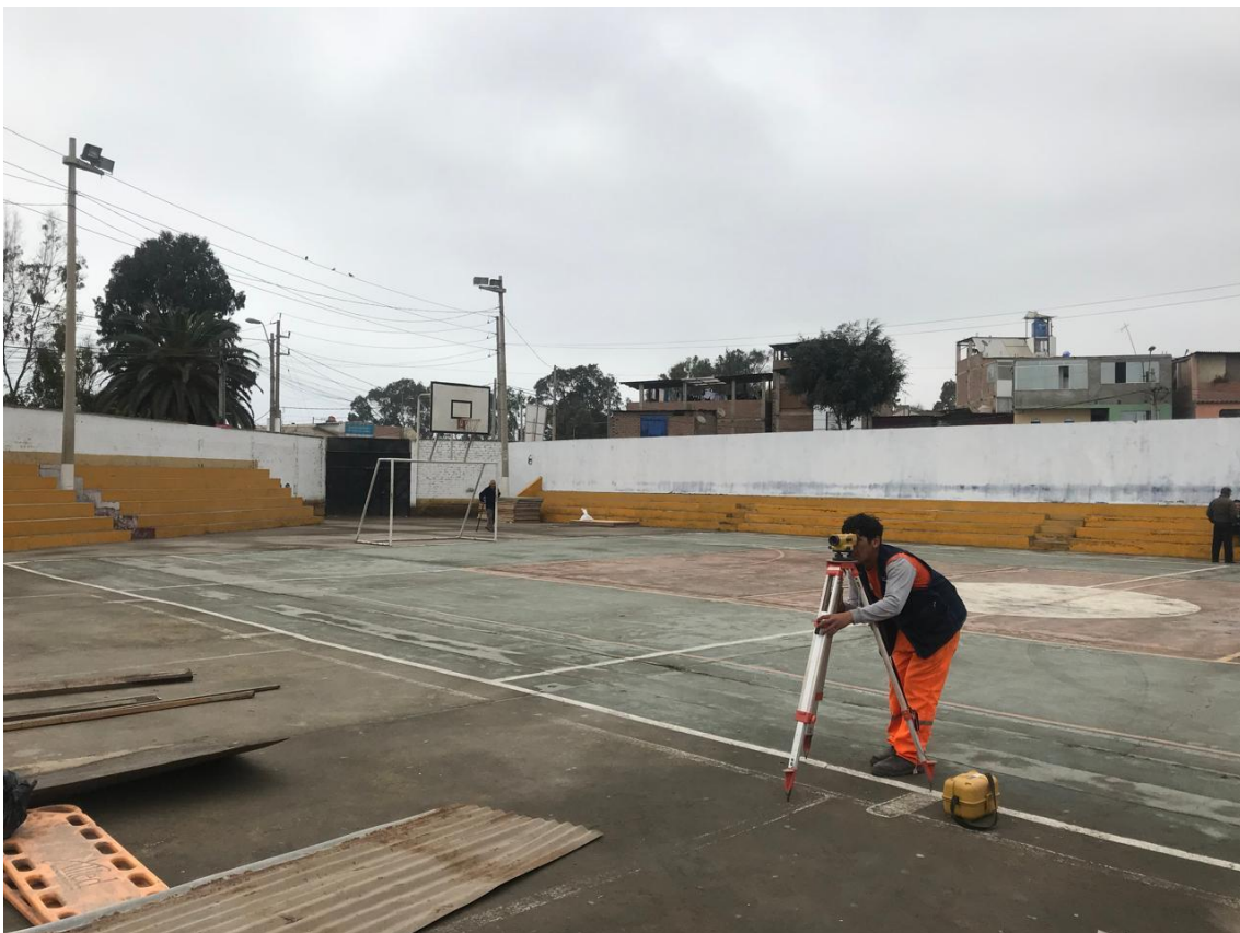
Figura 6. Inicio de actividades en Polideportivo, levantamiento topográfico
