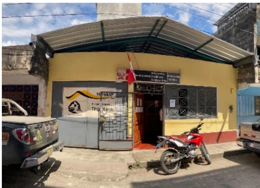
Figura 16. Fachada de oficina SERNANP Tingo María previa a intervención
