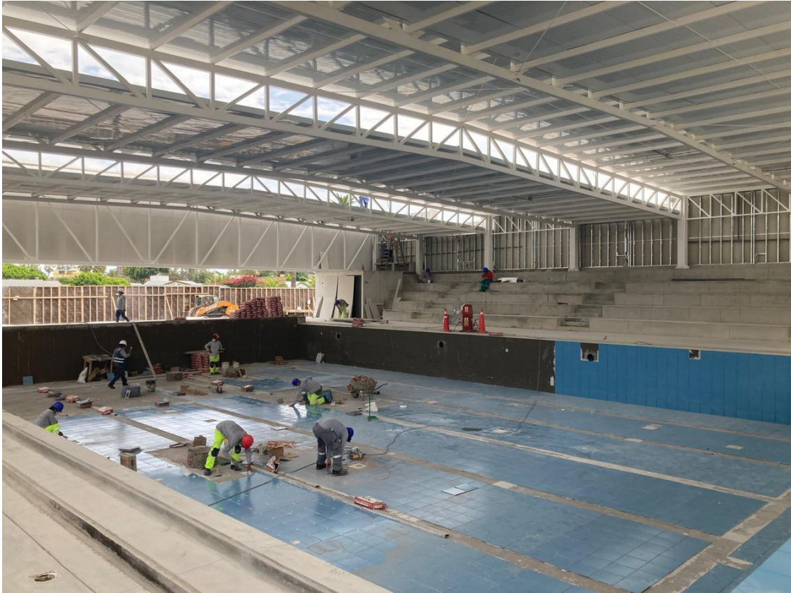
Figura 13. Colocación de enchapes en piscina Cambridge College
