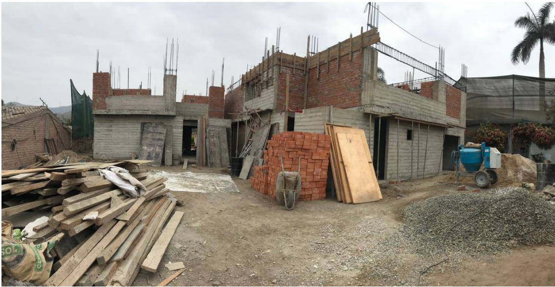
Figura 8. Fachada posterior de viviendas en Country Club La Planicie.
