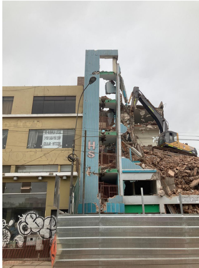
Figura 15. Demolición con maquinaria pesada
