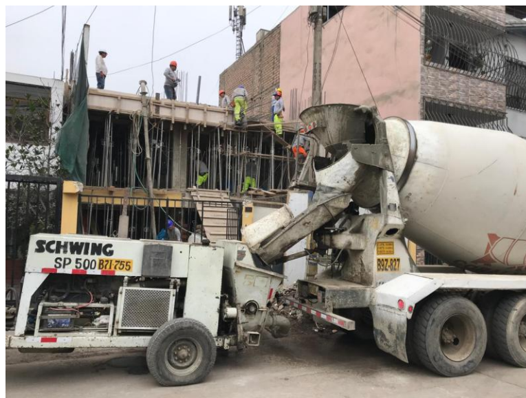
Figura 10. Vaciado de losa en vivienda Casa Ibañez
