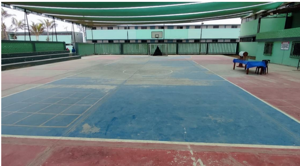
Vista interna en losa deportiva – Colegio Militar “Gran Marical Ramon Castilla”
