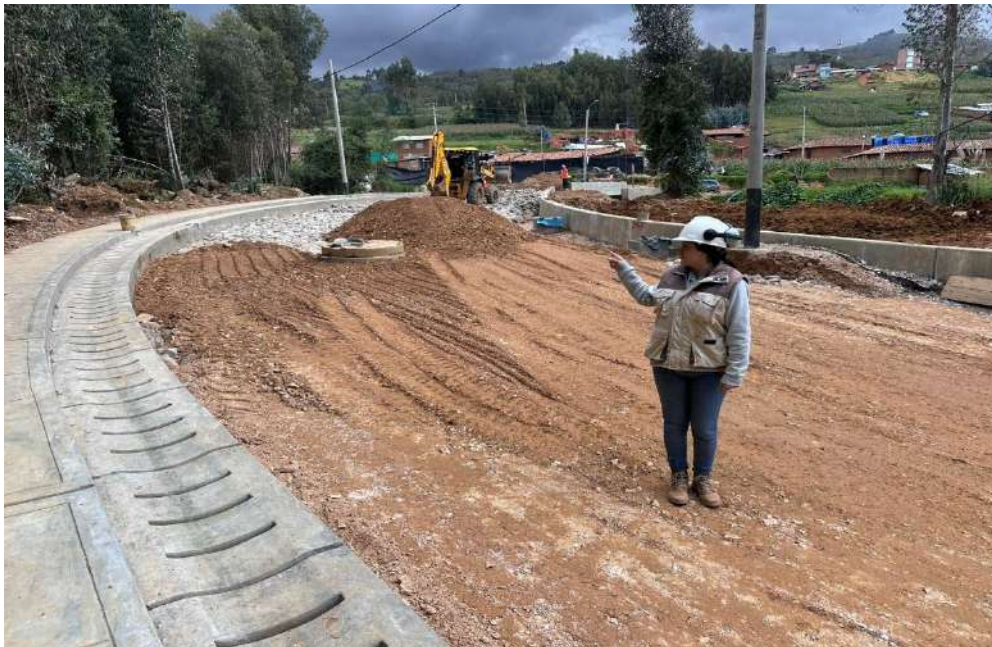
Figura 5 Supervisión de actividades constructivas durante la conformación de material en obra
