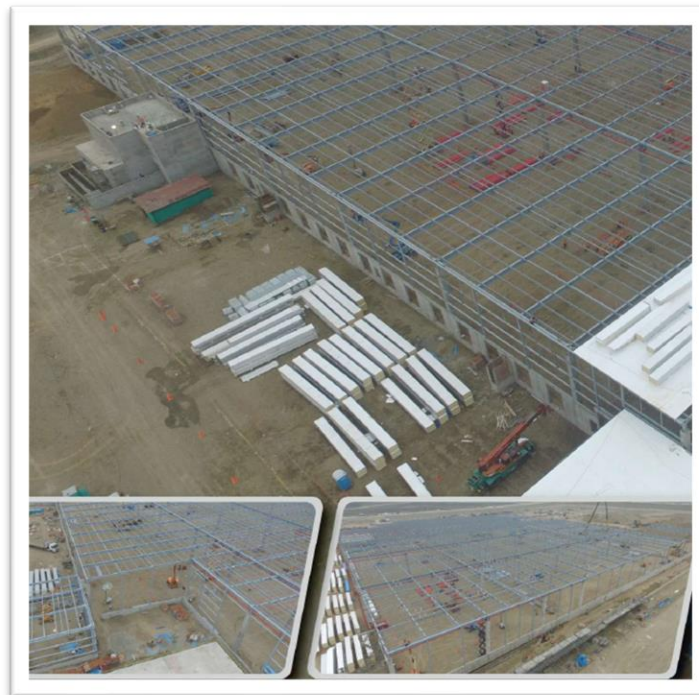
Figura 9: Proyecto CD Molitalia Lurín. Diseño y Construcción JCB Estructuras 2019
