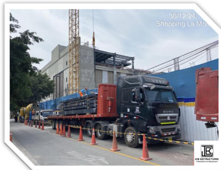
Figura 78: Proyecto Ampliación del Centro Comercial Shopping La Molina: Obra. Fuente: Elaboración propia.
