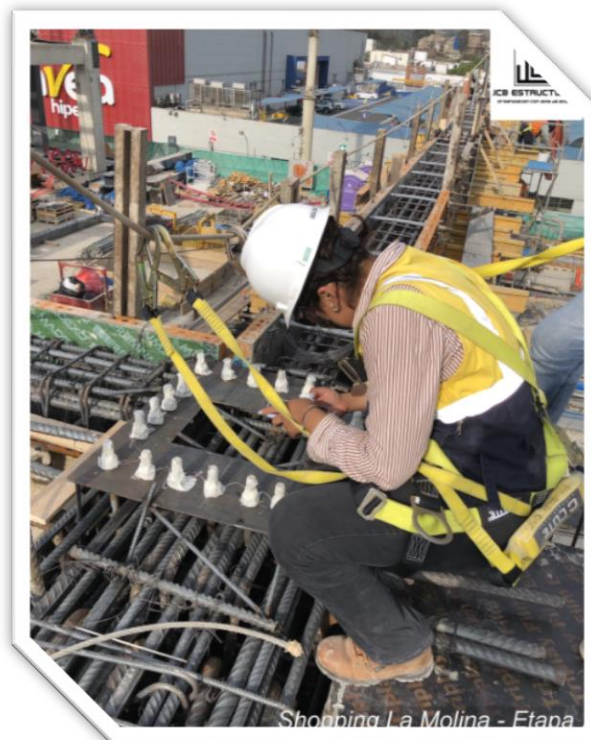
Figura 84: Proyecto Ampliación del Centro Comercial Shopping La Molina: Obra. Fuente: Elaboración propia.
