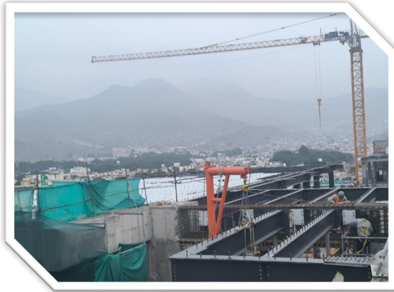
Figura 35: Proyecto Ampliación del Centro Comercial Shopping La Molina: Ubicación de torre grúa # 02
