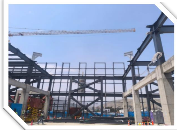
Figura 67: Proyecto Ampliación del Centro Comercial Shopping La Molina: Elementos auxiliares instalados en posición.
