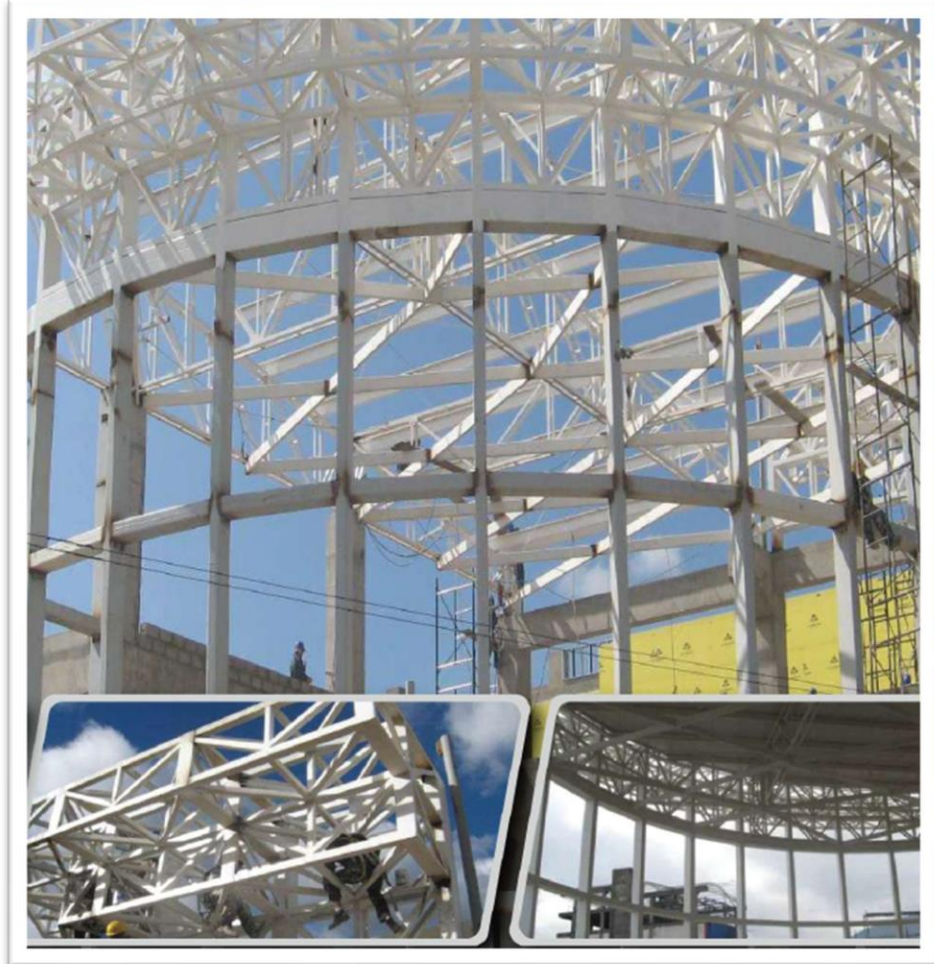
Figura 2: Edificación Centro Comercial Real plaza Huancayo. Diseño: JCB Estructuras, Construcción: JCB Estructuras (2010)
