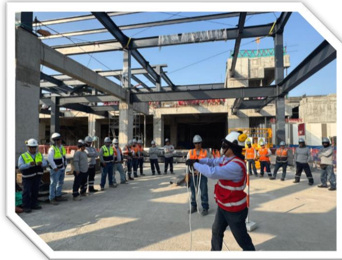
Figura 81: Proyecto Ampliación del Centro Comercial Shopping La Molina: Obra. Fuente: Elaboración propia.
