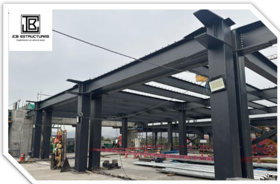
Figura 89: Proyecto Ampliación del Centro Comercial Shopping La Molina: Obra. Fuente: Elaboración propia.
