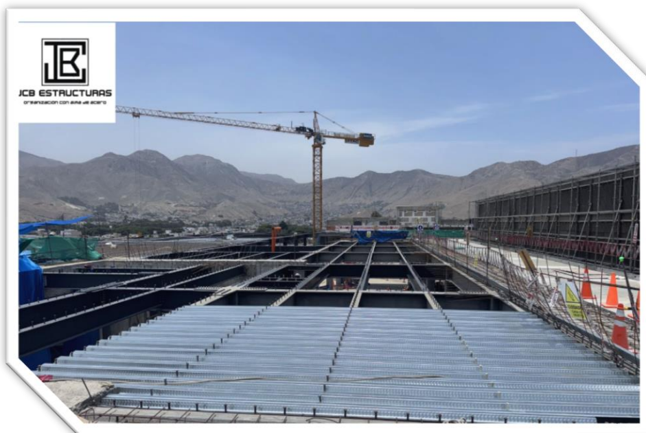
Figura 91: Proyecto Ampliación del Centro Comercial Shopping La Molina: Obra. Fuente: Elaboración propia.
