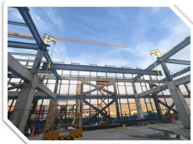
Figura 69: Proyecto Ampliación del Centro Comercial Shopping La Molina: Elementos auxiliares en proceso de izaje de viga.
