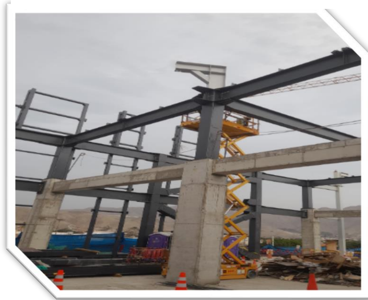
Figura 66: Proyecto Ampliación del Centro Comercial Shopping La Molina: Elementos auxiliares instalados en posición.
