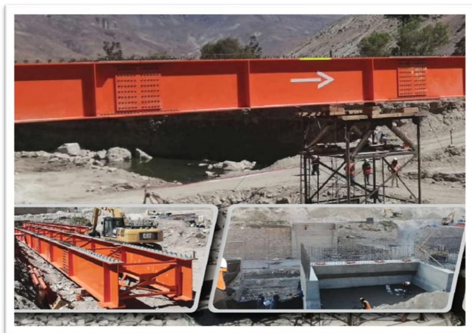
Figura 11: Puente Marjani, Ubicación Tacna Perú. Construcción JCB Estructuras 2020
