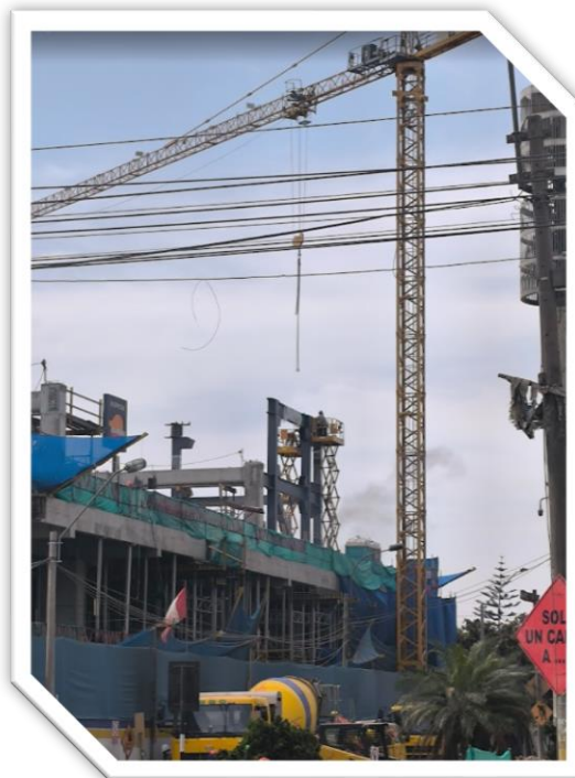
Figura 34: Proyecto Ampliación del Centro Comercial Shopping La Molina: Ubicación de torra grúa # 01
