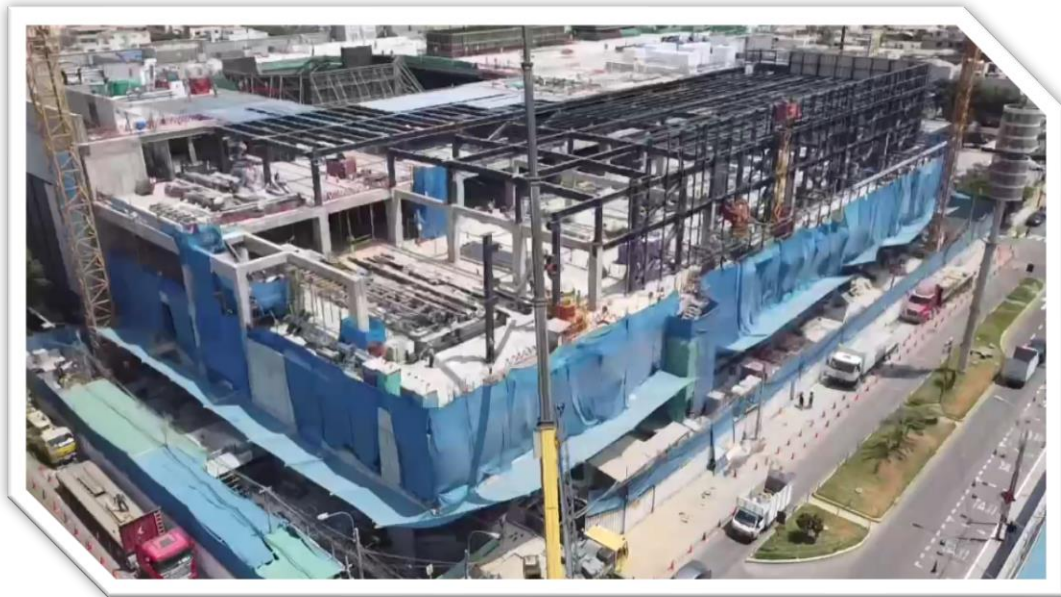
Figura 94: Proyecto Ampliación del Centro Comercial Shopping La Molina: Obra. Fuente: Elaboración propia.
