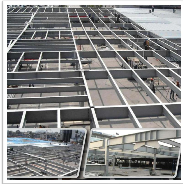
Figura 8: Proyecto Estacionamiento Jockey Plaza. Diseño y Construcción JCB Estructuras 2010
