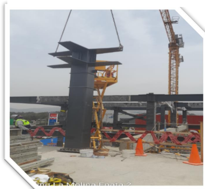
Figura 74: Proyecto Ampliación del Centro Comercial Shopping La Molina: Obra. Fuente: Elaboración propia.
