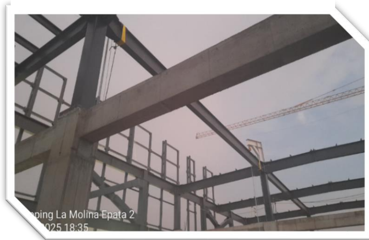
Figura 70: Proyecto Ampliación del Centro Comercial Shopping La Molina: Viga metálica instalada en posición final.
