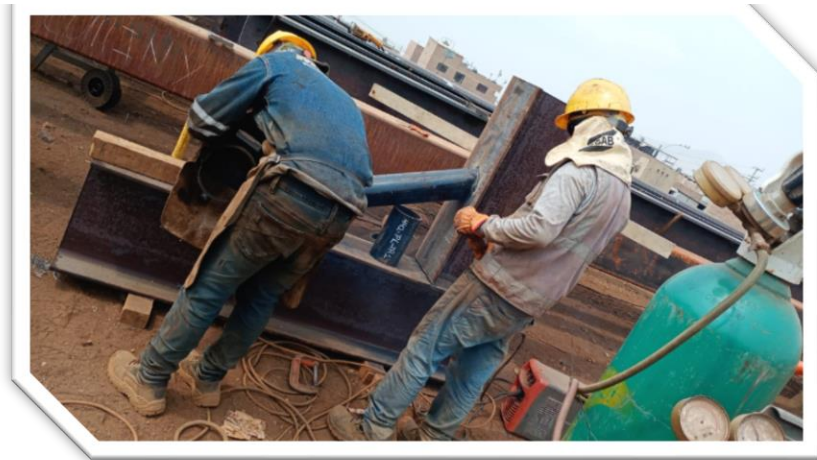
Figura 56: Proyecto Ampliación del Centro Comercial Shopping La Molina: Proceso de soldadura de elemento auxiliar.
