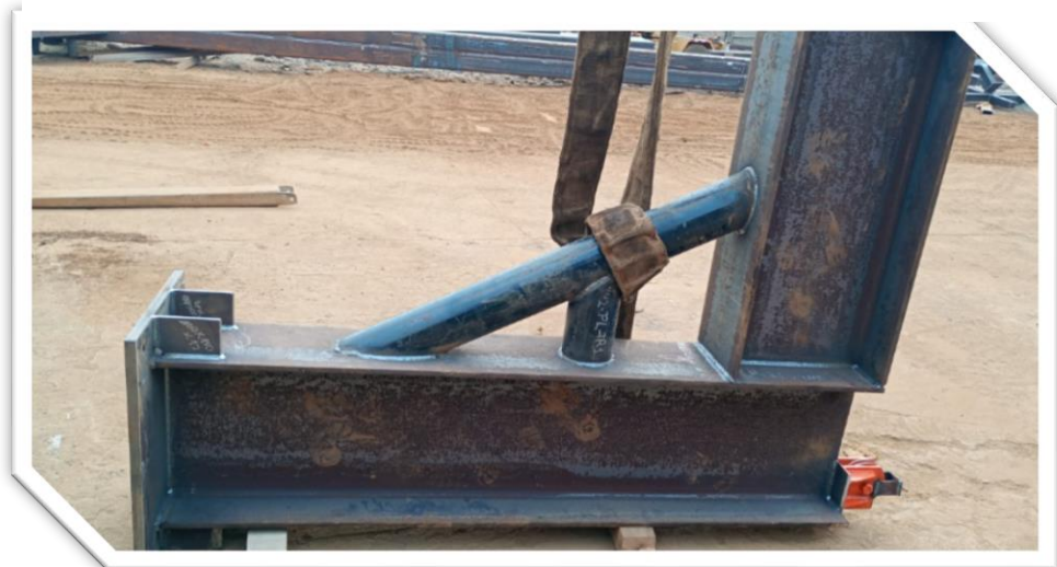
Figura 57: Proyecto Ampliación del Centro Comercial Shopping La Molina: Proceso de soldadura de elemento auxiliar.
