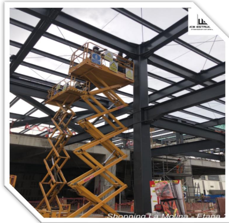
Figura 86: Proyecto Ampliación del Centro Comercial Shopping La Molina: Obra. Fuente: Elaboración propia.
