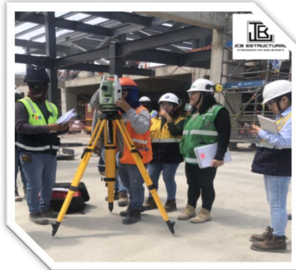
Figura 83: Proyecto Ampliación del Centro Comercial Shopping La Molina: Obra. Fuente: Elaboración propia.
