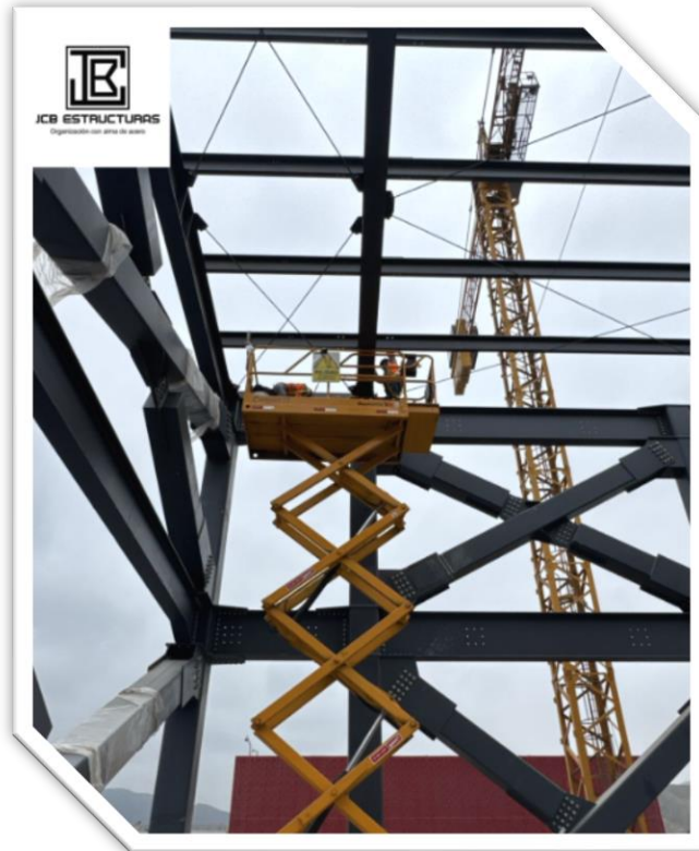
Figura 77: Proyecto Ampliación del Centro Comercial Shopping La Molina: Obra. Fuente: Elaboración propia.
