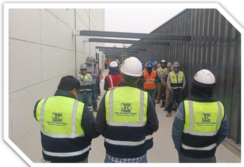
Figura 95: Proyecto Ampliación del Centro Comercial Shopping La Molina: Obra. Fuente: Elaboración propia.
