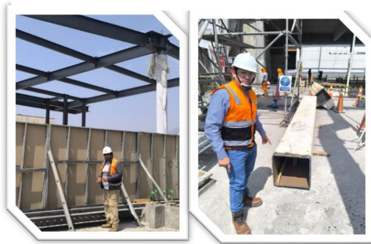
Figura 22: Proyecto Ampliación del Centro Comercial Shopping La Molina: Habilitación de perfiles metálicos para maniobra de izaje
