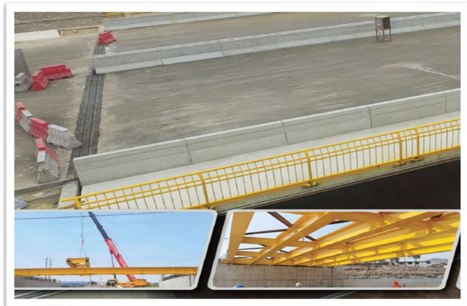
Figura 14: Proyecto Puente Circunvalación Ubicación: Lima - Perú Construcción JCB Estructuras 2018
