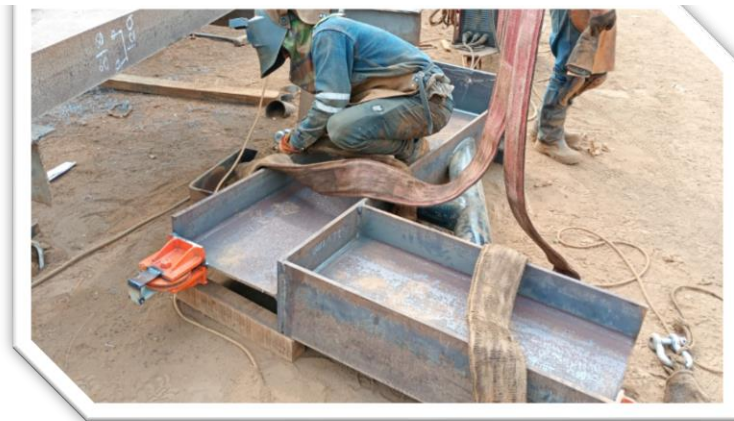
Figura 56: Proyecto Ampliación del Centro Comercial Shopping La Molina: Proceso de soldadura de elemento auxiliar.
