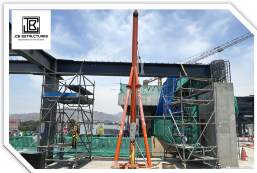
Figura 87: Proyecto Ampliación del Centro Comercial Shopping La Molina: Obra. Fuente: Elaboración propia.
