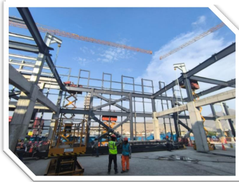
Figura 68: Proyecto Ampliación del Centro Comercial Shopping La Molina: Elementos auxiliares instalados con tecles en posición.
