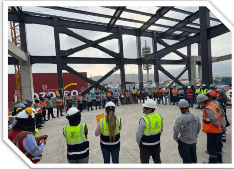
Figura 88: Proyecto Ampliación del Centro Comercial Shopping La Molina: Obra. Fuente: Elaboración propia.
