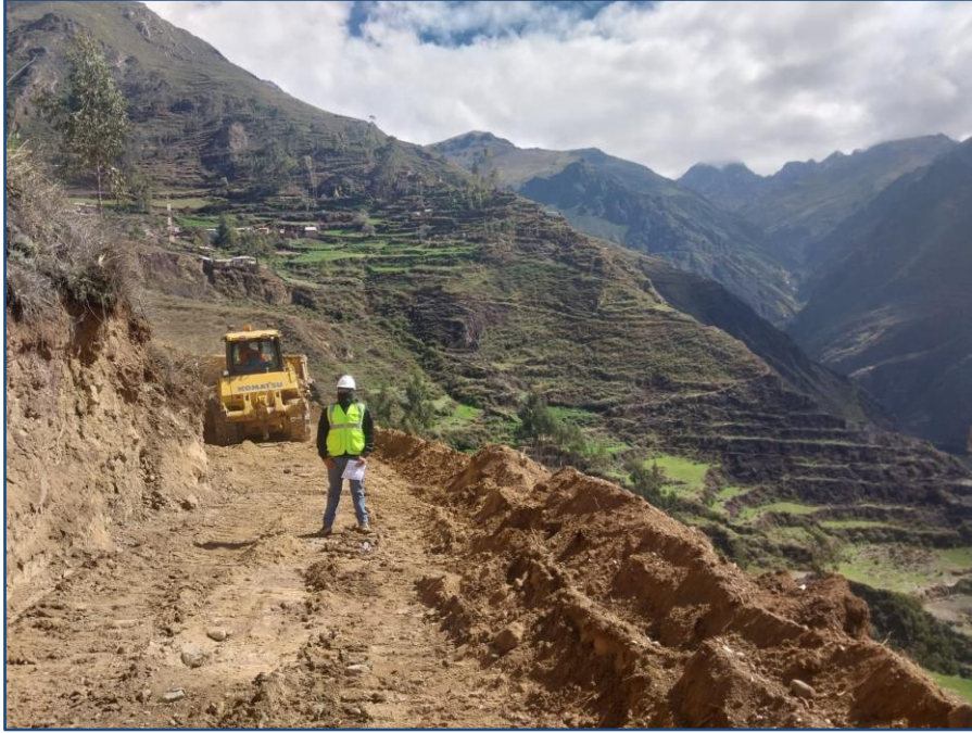
SE OBSERVA AL INGENIERO RESIDENTE SUPERVISANDO LA EJECUCIÓN EN OBRA
