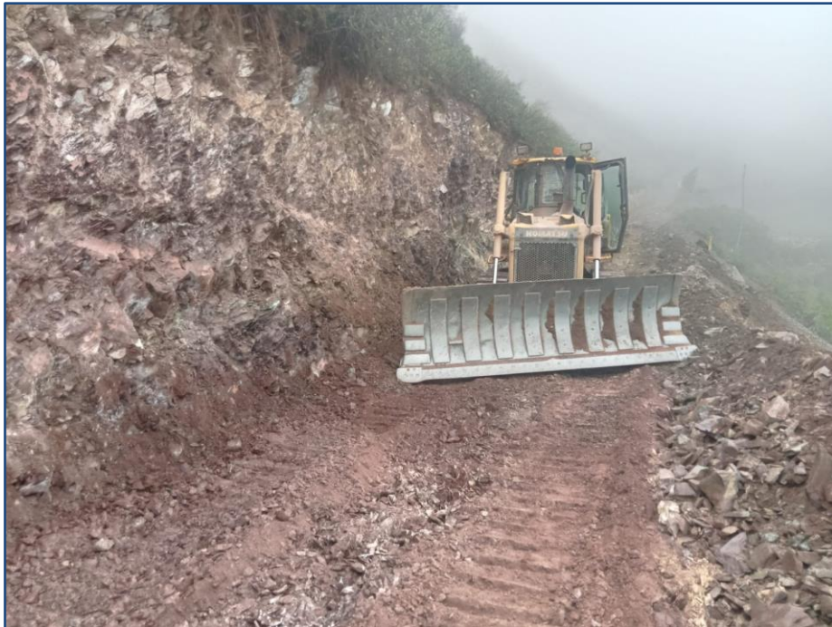
SE OBSERVA AL TRACTOR ORUGA REALIZANDO CORTE DE ROCA SUELTA
