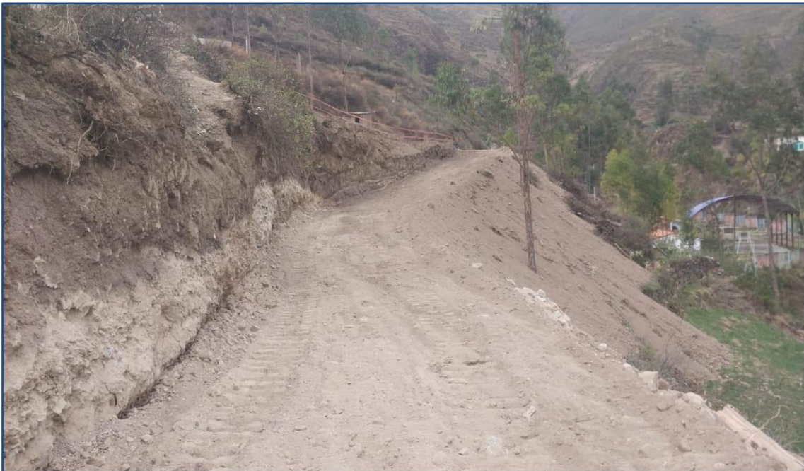
FOTOGRAFÍA DONDE SE OBSERVA LA APERTURA DE LA TROCHA.
