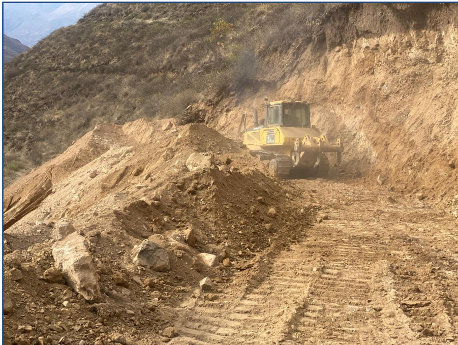
SE OBSERVA AL TRACTOR ORUGA REALIZANDO LA PRIMERA CURVA
