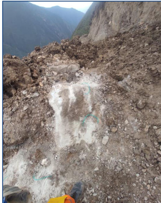
EN ESTA FOTOGRAFIA SE OBSERVA ROCA FIJA CON EXPLOSIVOS INSTALADOS PARA FRAGMENTAR LA ROCA
