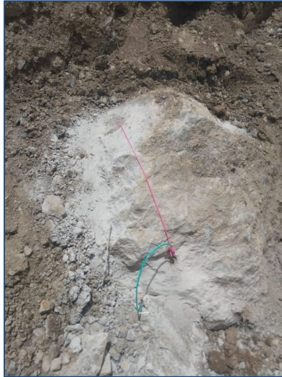
SE OBSERVA UN ÁREA DE ROCA FIJA CON EXPLOSIVOS INSTALADOS PARA FRAGMENTAR LA ROCA
