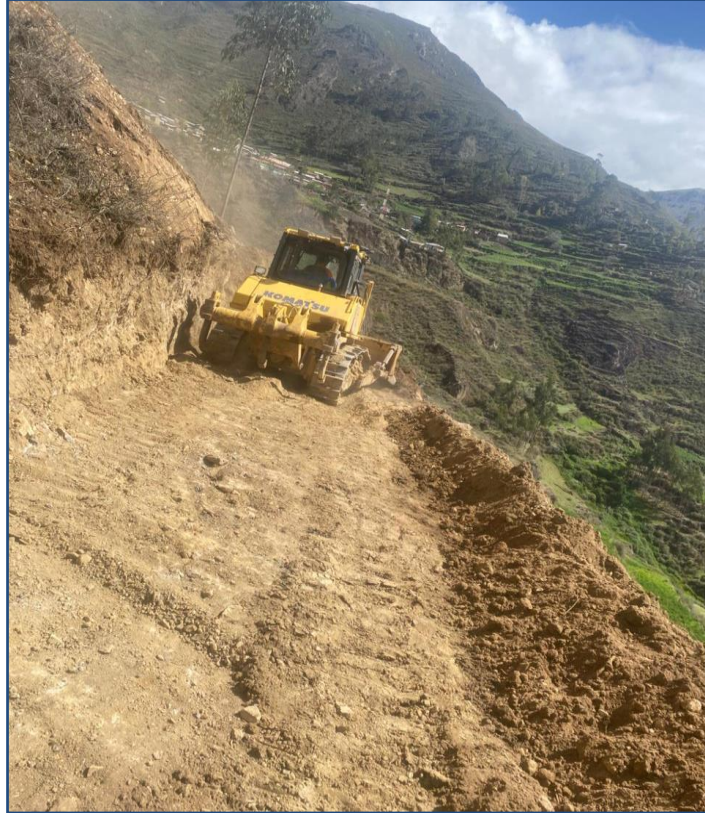
SE OBSERVA AL TRACTOR ORUGA REALIZANDO CORTE DE MATERIAL SUELTO
