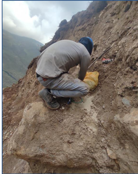
SE OBSERVA AL PERSONAL TÉCNICO INSTALANDO LOS EXPLOSIVOS
