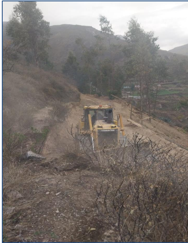
EN ESTA FOTOGRAFÍA SE OBSERVA AL TRACTOR ORUGA CREANDO LA TROCHA CARROZABLE
