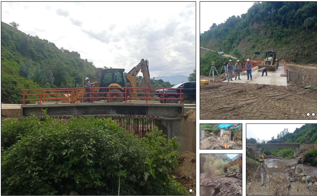
○ SELECCIÓN DE CUATRO TRABAJOS POR PROYECTO: REPARACIÓN DEL PUENTE ANDRÉS BELLEROS, PUENTE MULTISERVICIO PUENTE ASCAT Y PUENTE ANDRÉS AVELINO CÁLCERES EN EL DISTRITO DE USALUI, PROVINCIA OTUSCO, DEPARTAMENTO LA LIBERTAD ○○
