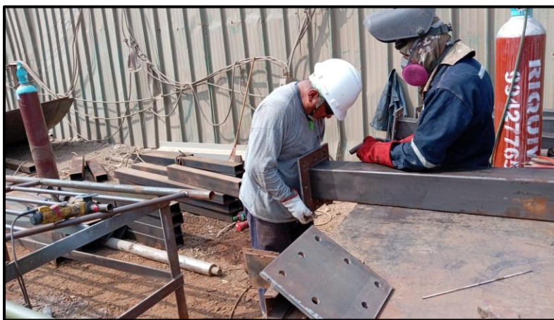
Figura 6: Ensamble y soldadura de columnas sobre placas base en taller
