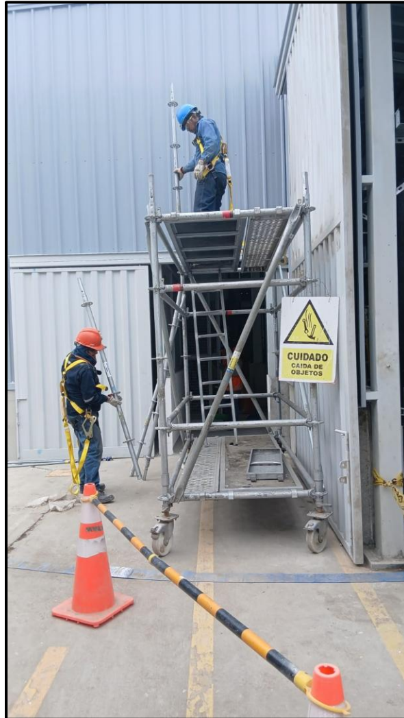
Figura 20: Operarios trabajando en altura con andamio y arnés de seguridad
