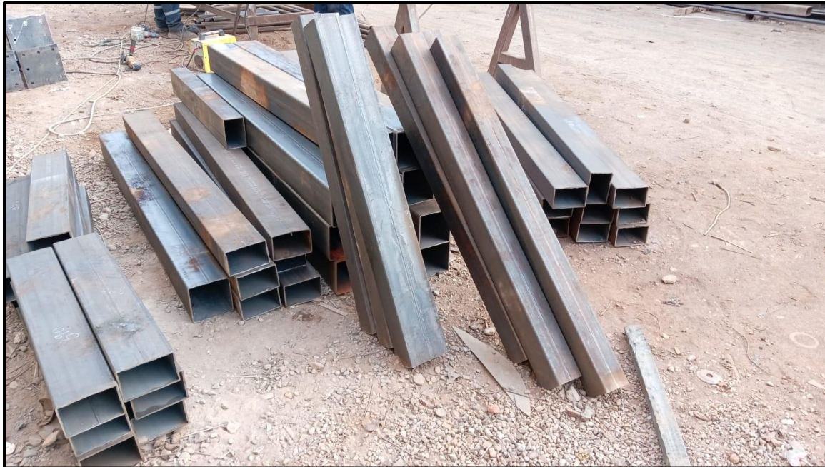
Figura 5: Acopio inicial de perfiles tubulares en área de almacenamiento
