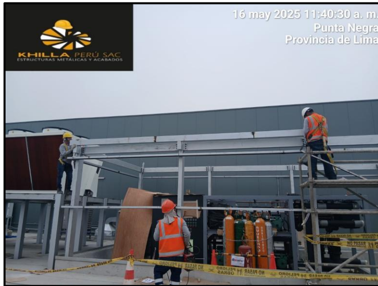
Figura 13: Instalación de vigas superiores en la plataforma del sistema de refrigeración
