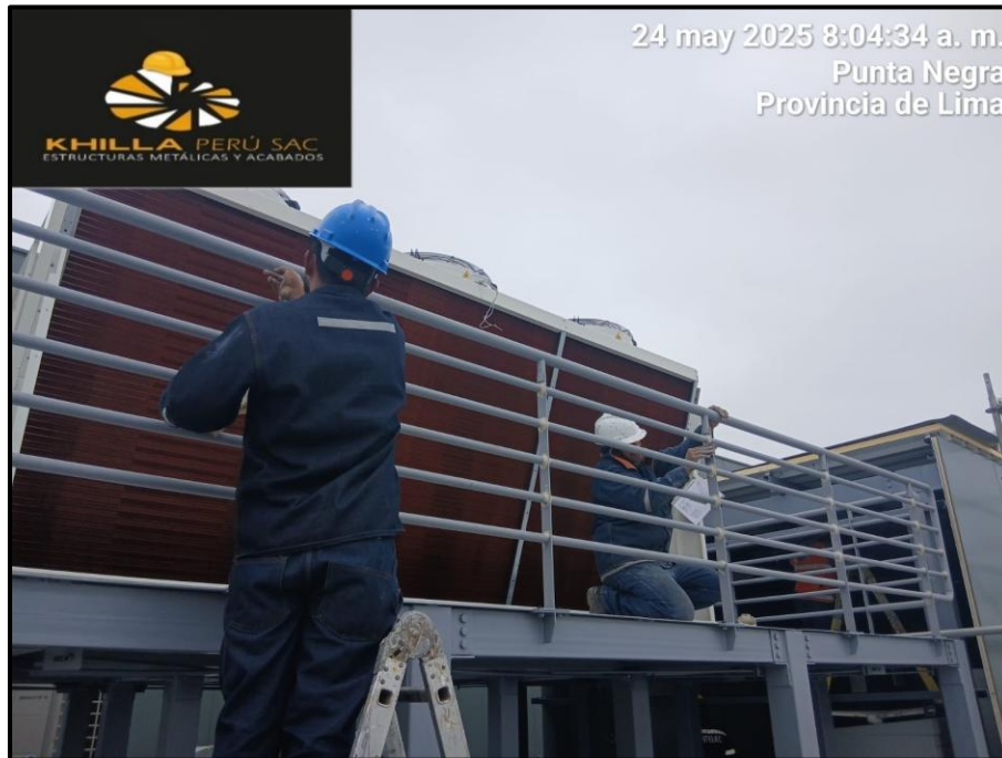
Figura 22: Instalación y fijación de barandas perimetrales alrededor del equipo Gas Cooler.
