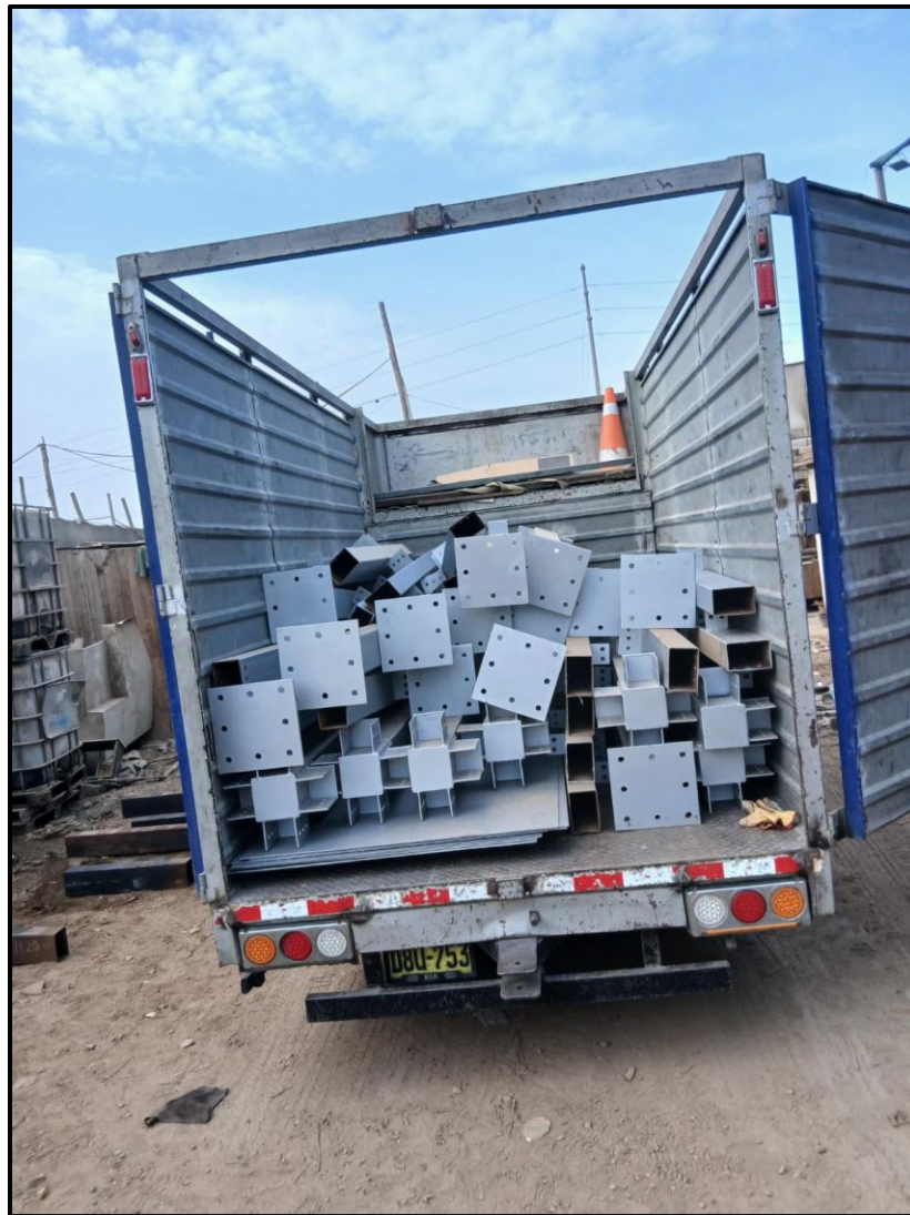
Figura 9: Camión cargado con perfiles metálicos pintados listo para traslado
