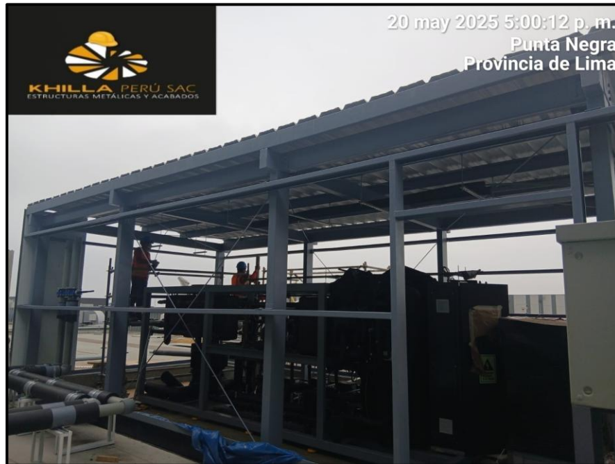
Figura 17: Avance del techado metálico y fijación de paneles
