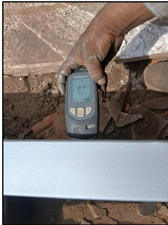
Figura 8: Medición de espesor de pintura sobre perfil tubular
