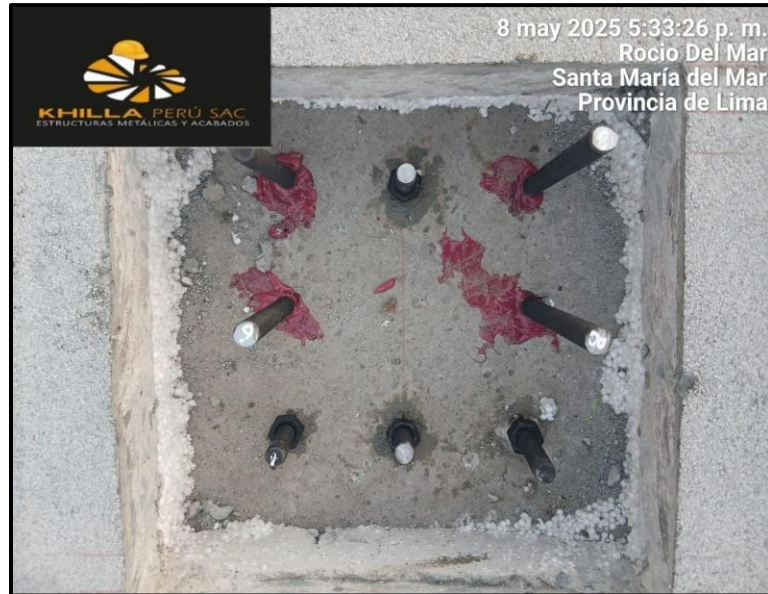
Figura 11: Aplicación de Sikadur-31 en plinto de concreto para fijación de espárragos
