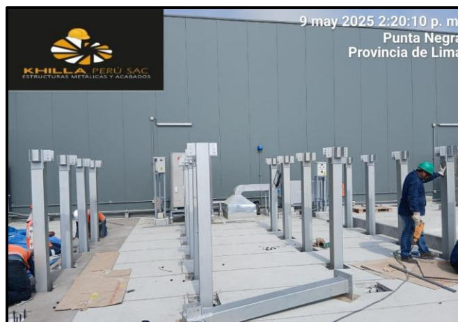
Figura 14: Colocación inicial de “zetas” y elementos horizontales
