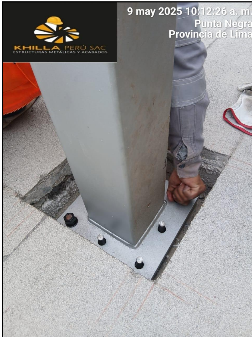
Figura 12: Fijación y plomeo de columna metálica sobre espárragos
