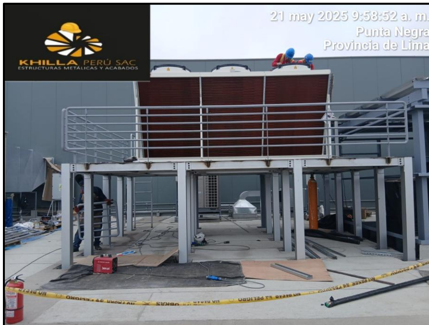
Figura 15: Instalación de barandas perimetrales en plataforma elevada
