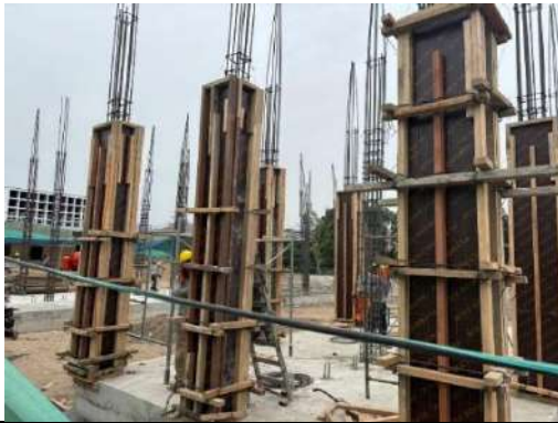
FOTO N°03. Encofrado de columna
