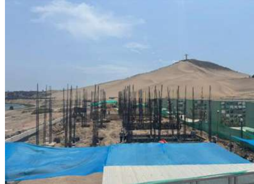
FOTO N°02. Armado de columnas
