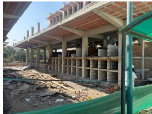
FOTO N°06. Asentado de bloque P-10
