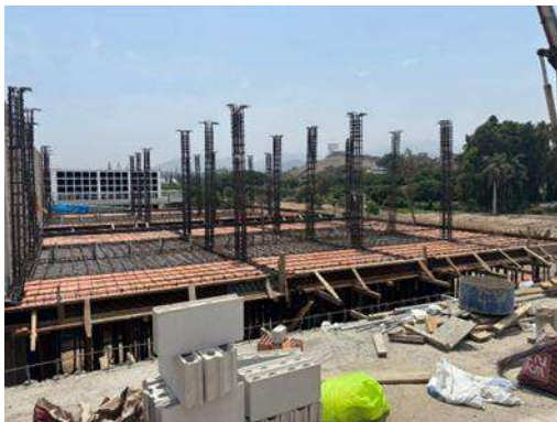
FOTO N°05. Encofrado de losa maciza entre nichos
