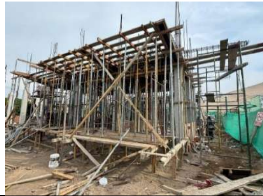
FOTO N°04. Encofrado de losa aligerada
