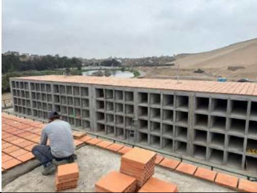
FOTO N°07. Asentado de ladrillo pastelero
