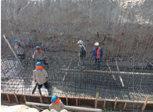
FOTO N°01. Armado de acero para muro de contención
