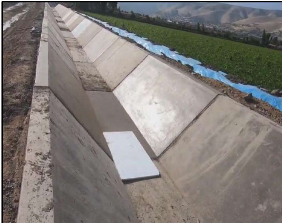
Rehabilitación de la Captación y Canal Huáncar Alto
