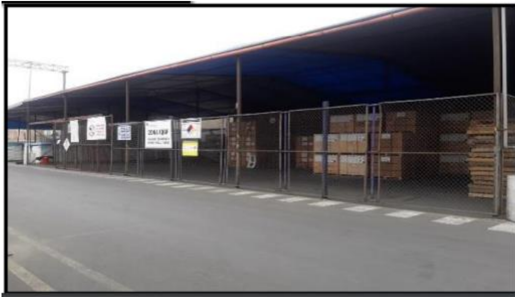
Figura 39, Zona IQBF después de la ampliación.
