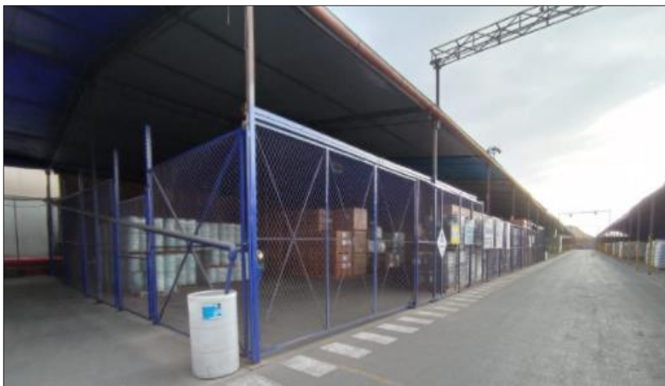
Figura 38, Zona IQBF después de la ampliación.
