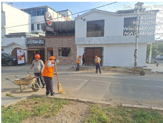
Fotografía 12: Limpieza final de obra.
