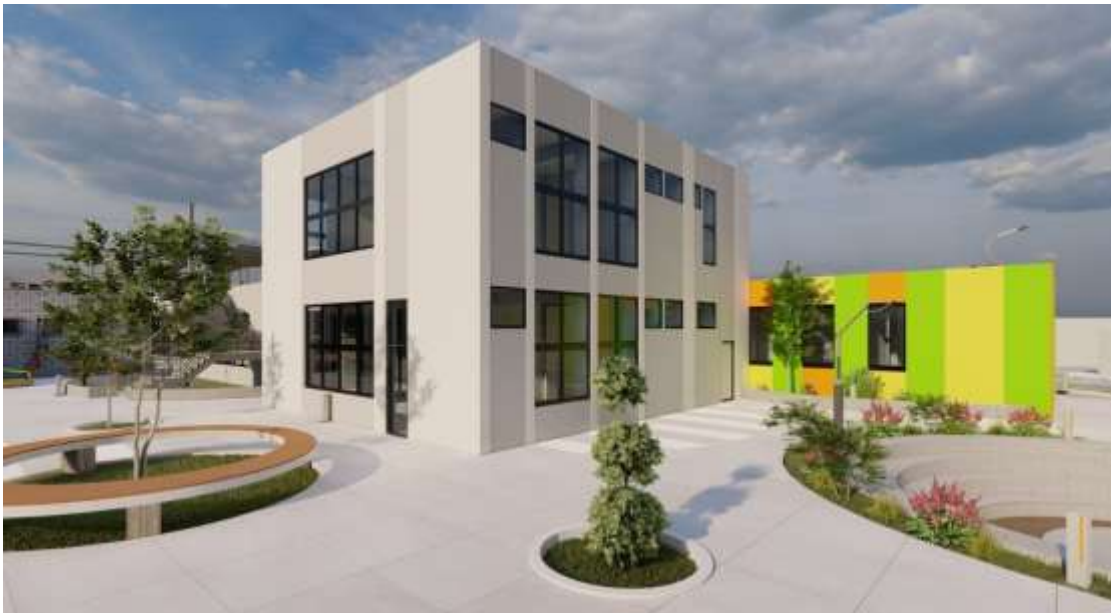
Figura 84. Vista de Agencia bancaria
