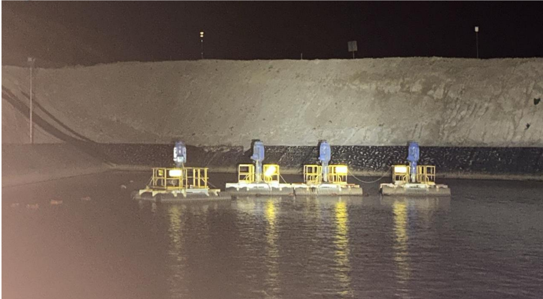
Figura 6 Nuevo sistema de bombeo
