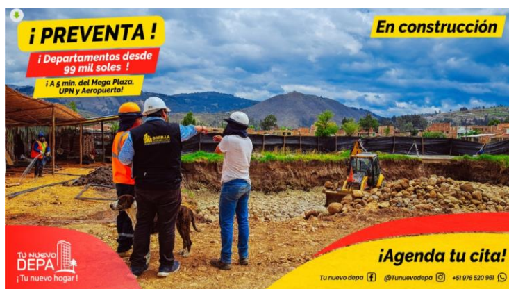
Figura 3: Fotografías en obra.
