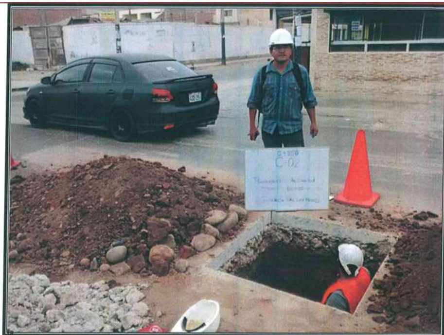
Extracción de la muestra de la calicata C-02 (Progresiva 0+250)
