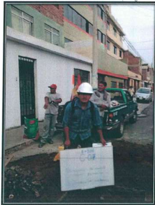
Extracción de la muestra de la calicata C-07 (Progresiva 1+500)
