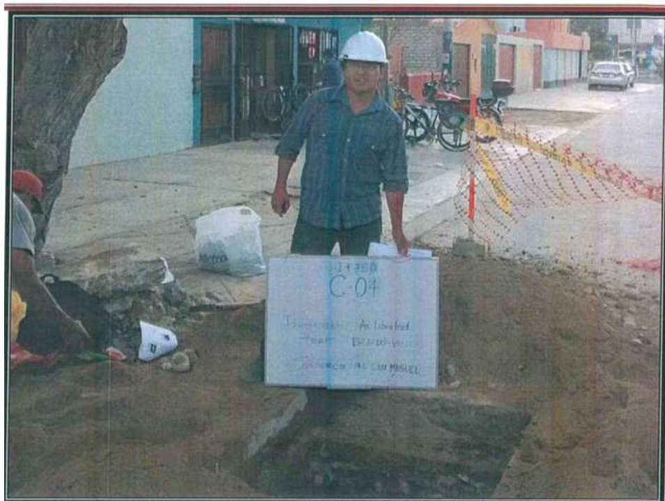
Extracción de la muestra de la calicata C-04 (Progresiva 0+750)
