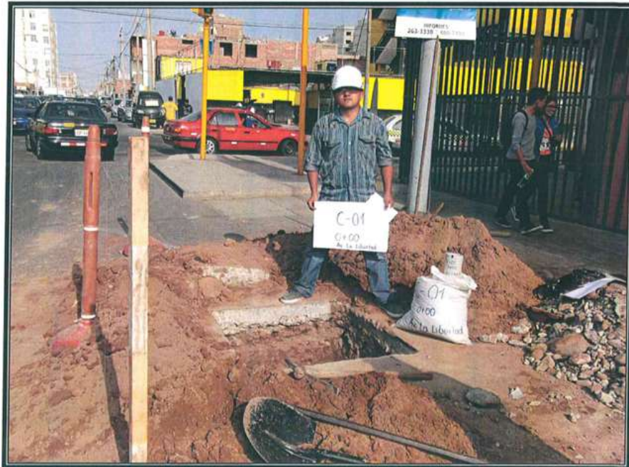
Extracción de la muestra de la calicata C-01 (Progresiva 0+000)
