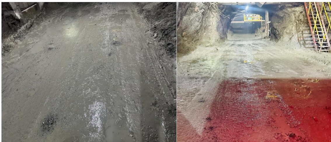
Figura 28. Colpa zona carguío de volquetes
