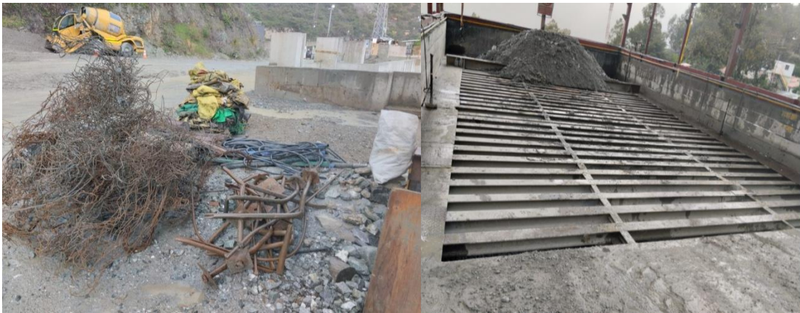
Figura 25. Colpa parrilla rotura de banco
