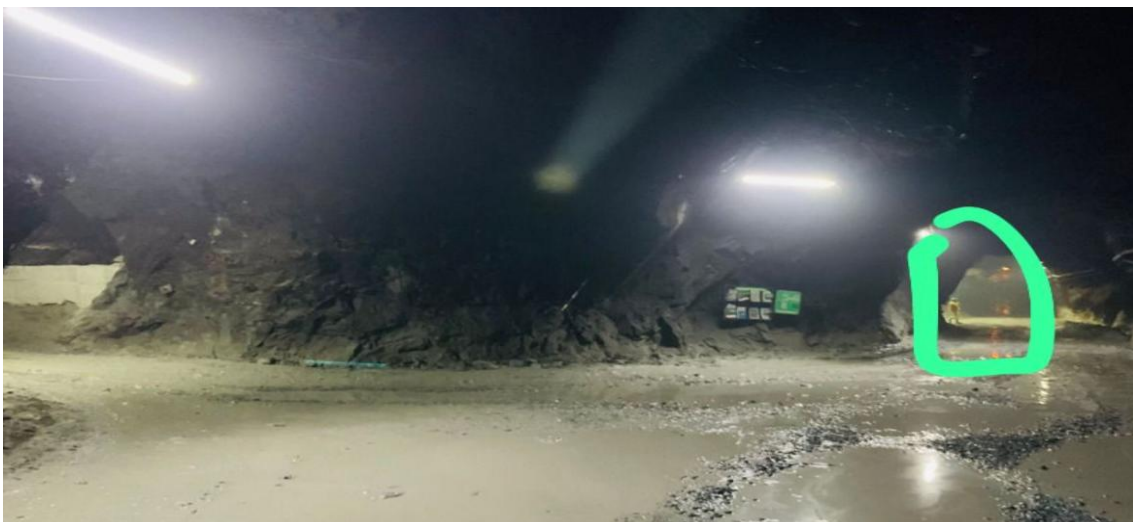
Supervisión zona de carguío
