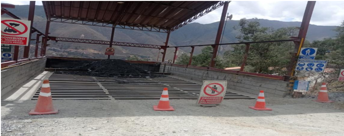
Supervisión de la parrilla sobre la rotura de banco
