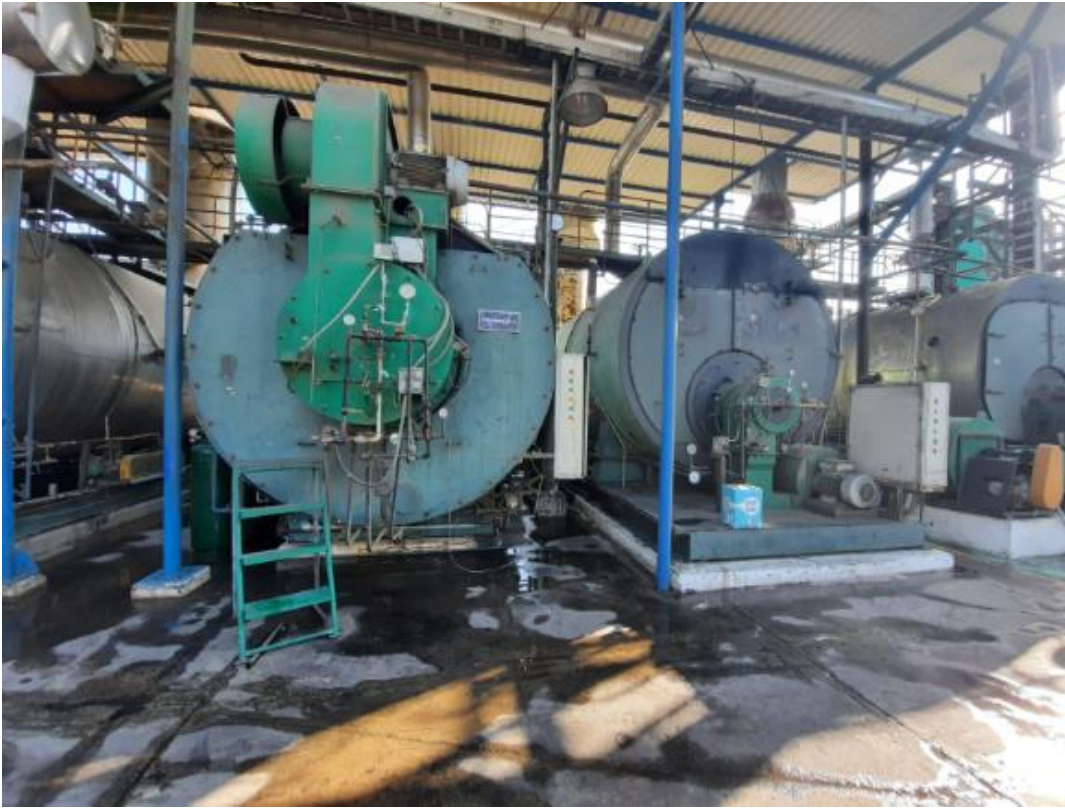
Anexo N° 13 Tanque de agua blanda
