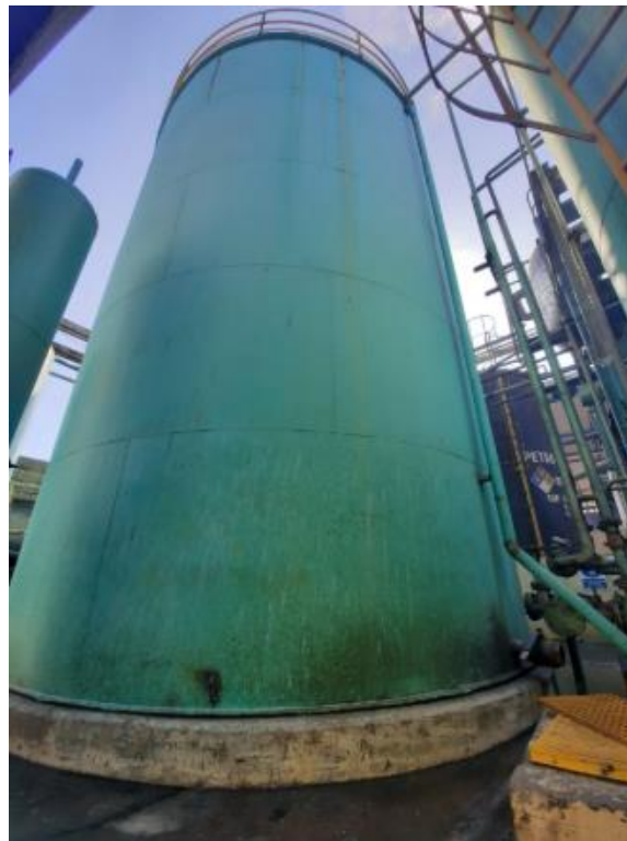
Anexo N° 14 Sistema de bombeo de agua de alimentación a calderas
