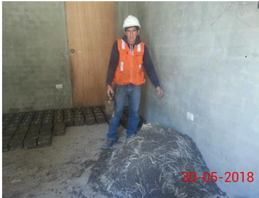
Figura 17. Mezcla Preparada para la Elaboración del Adobe.
