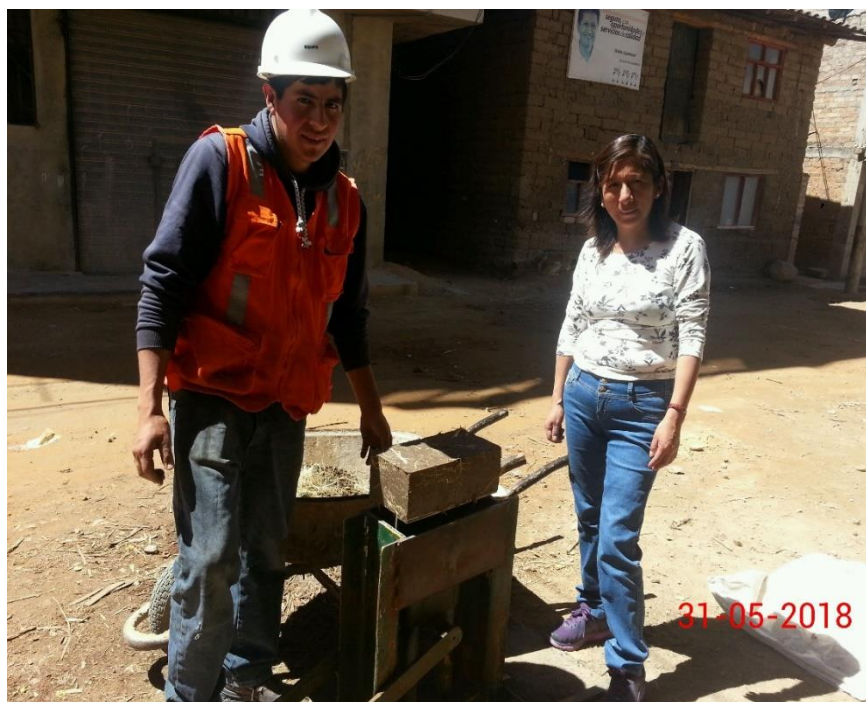
Figura 22. Elaboración del Adobe con la Visita del Laboratorista.
