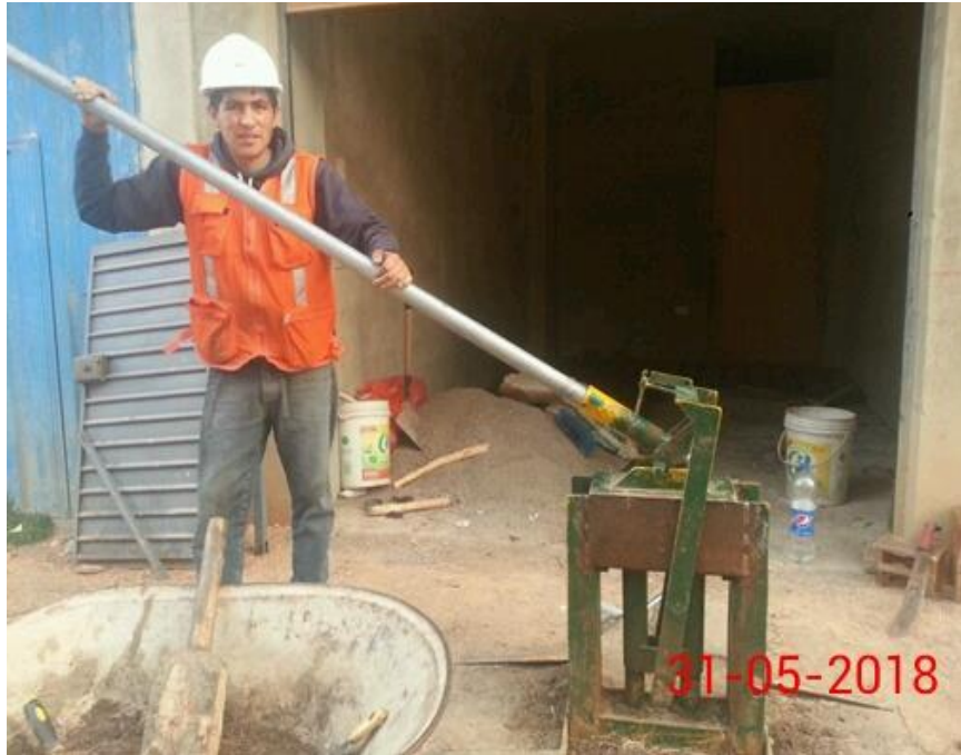
Figura 19. Compactación del Adobe con la Maquina Cinva RAM.
