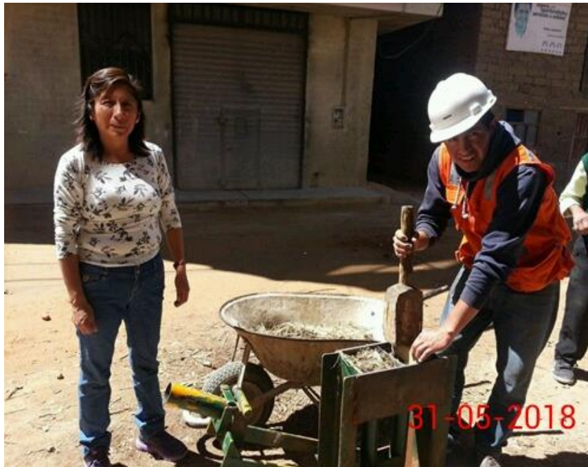
Figura 21. Elaboración del Adobe con la Visita del Laboratorista.
