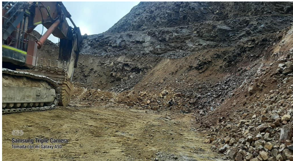
Frente de minado con Deck
