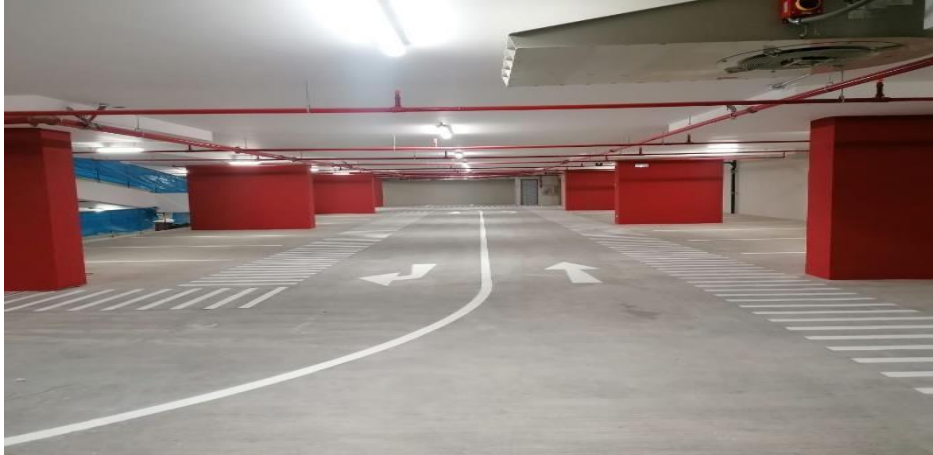
Acabados de pintado en zona de estacionamiento
