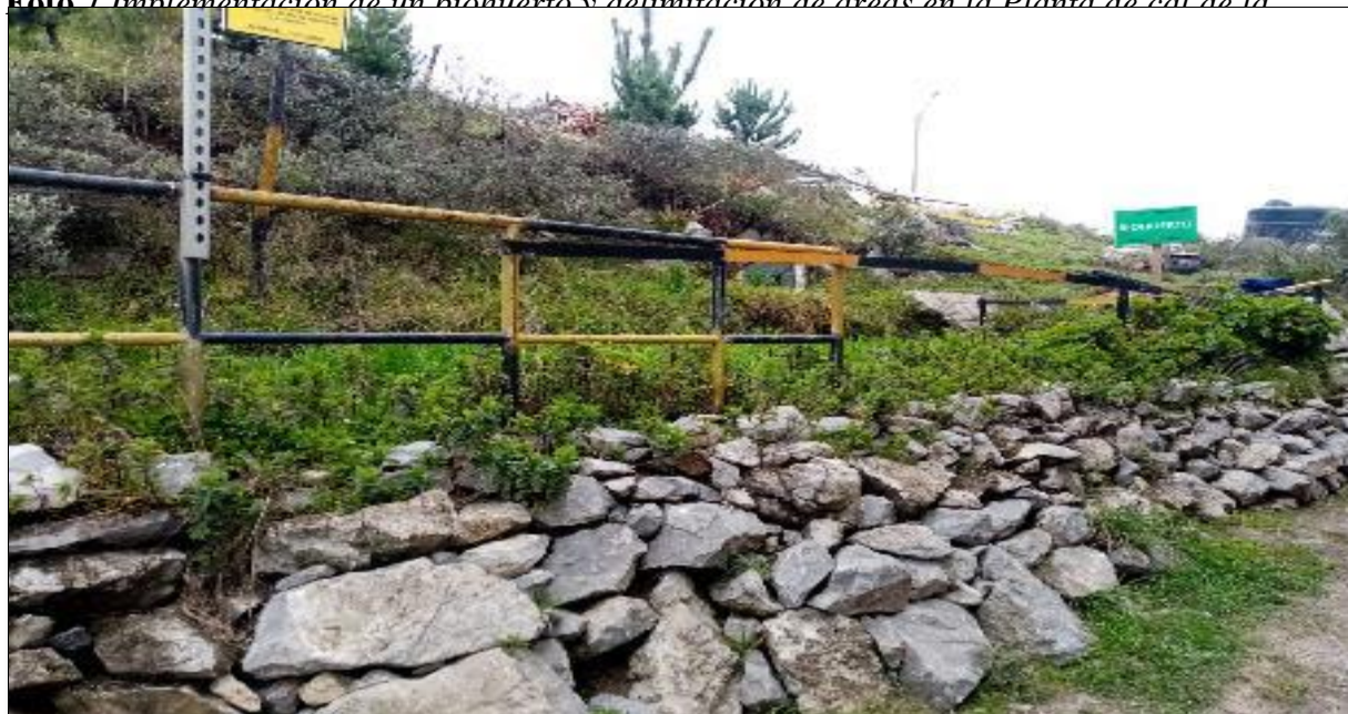
Foto 9 Implementación de un biohuerto y delimitación de áreas en la Planta de cal de la empresa
