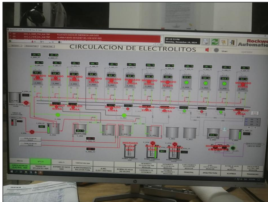
Figura 36. Equipos migrados en la nueva sala eléctrica 70.
