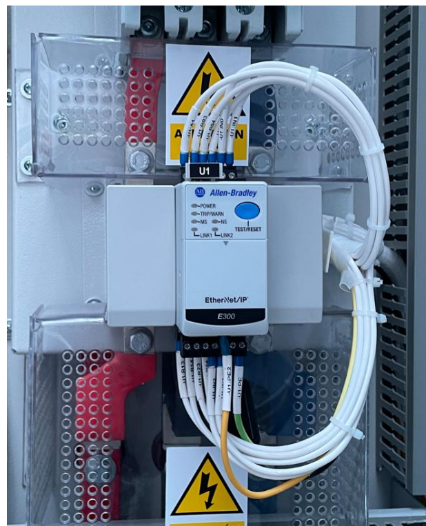
Figura 70. Relé electrónico E300 para sistema de bypass del Soft starter SMC50.
