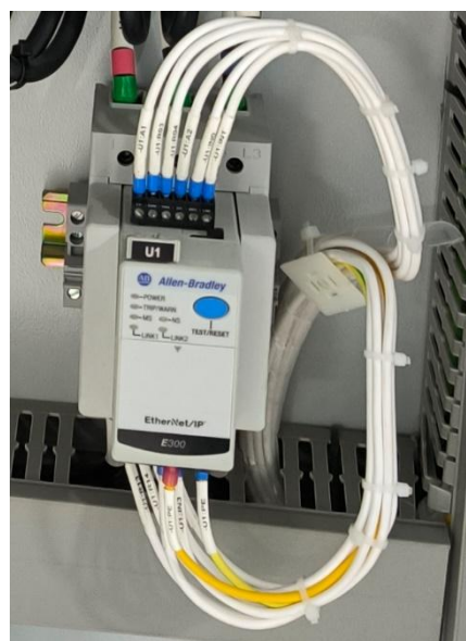
Figura 68. Relé electrónico E300 para sistema de bypass del variador PowerFlex 755.
