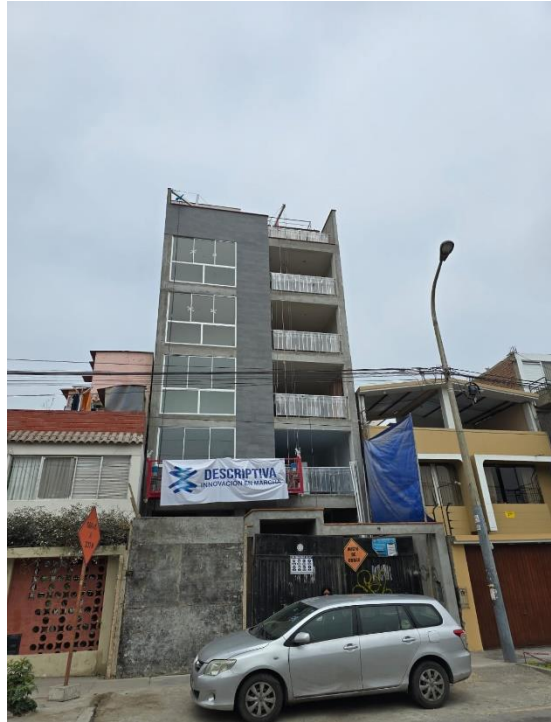
Anexo 1 – Fachada proyecto Residencial la luz culminado en un 75%
