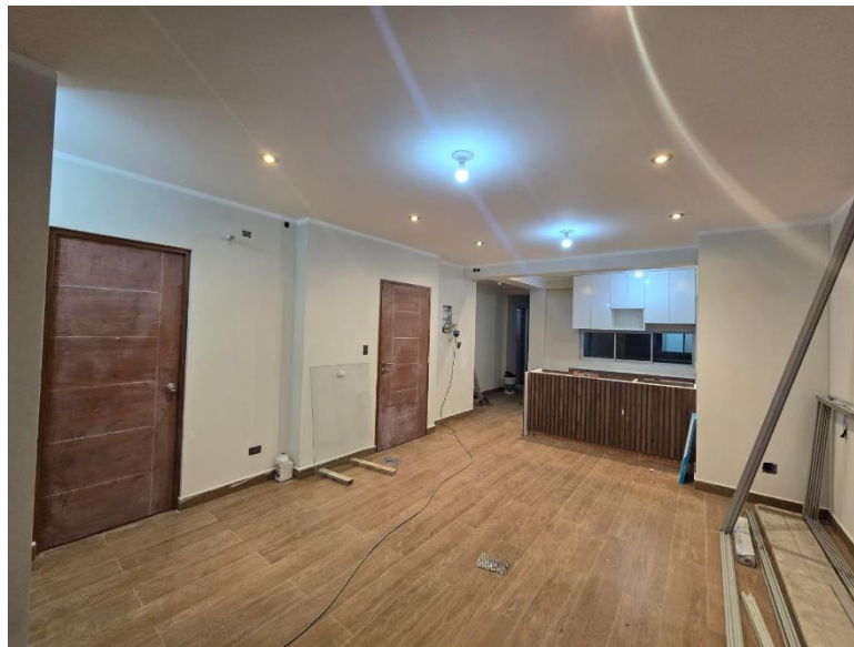
Anexo 2 – vista interna de departamento típico proyecto Residencial la luz culminado en un 95%
