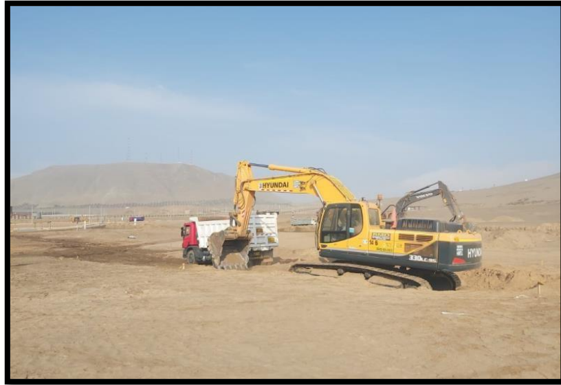
Figura 8. Corte con excavadora. (Fuente: Elaboración propia.)
