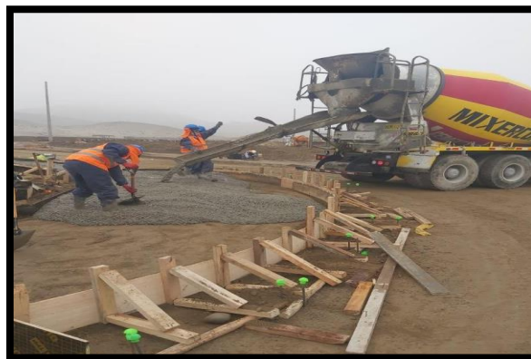
Figura 13. Vaciado de veredas. (Fuente: Elaboración propia.)
