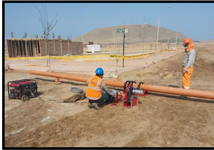
Figura 10. Instalación de tuberías HDPE con polifusión.
