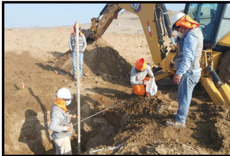
Figura 9. Excavación para buzones de saneamiento (Fuente: Elaboración propia.)
