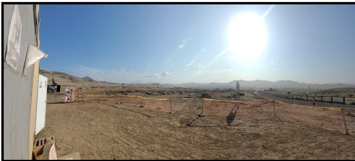
Figura 3. Imagen de la Obra (Fuente: Elaboración propia).
