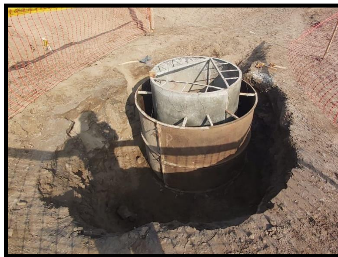
Figura 11. Encofrado de buzones de saneamiento.
