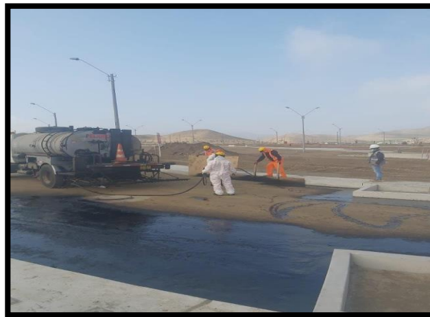
Figura 14. Imprimado de vías. (Fuente: Elaboración propia.)
