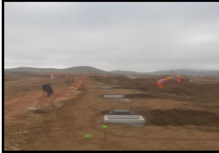
Figura 12. Instalación de cajas de agua y cajas de registro. (Fuente: Elaboración propia.)
