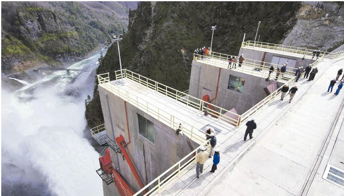
Figura 5 Central Hidroeléctrica Santa Teresa
