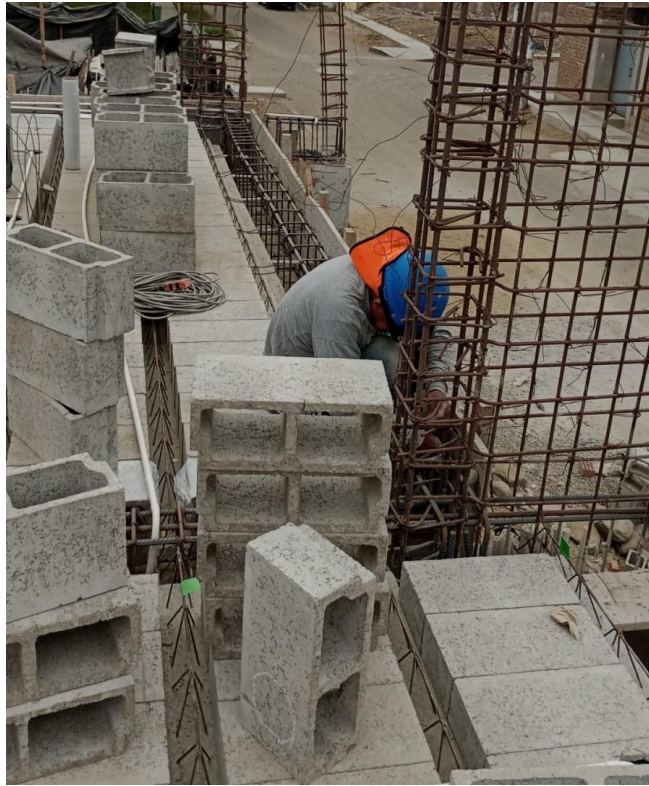
Figura 27 Armado de Columna en el Segundo Nivel
