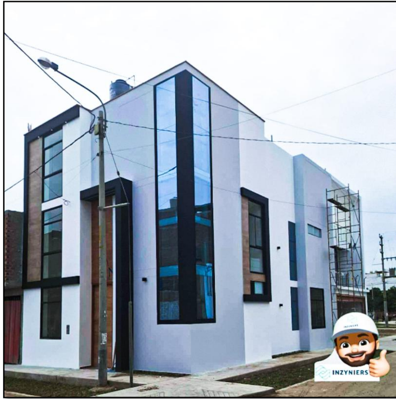
Figura 45 Enchapado Exterior Culminado
