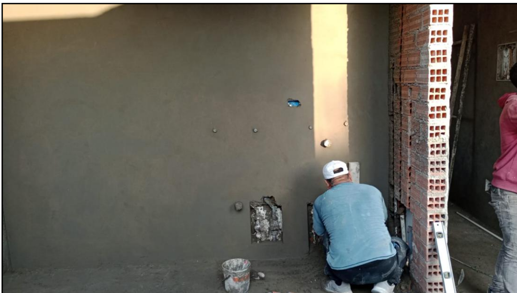
Figura 36 Colocación de Malla en Puntos de Instalaciones Sanitarias y Eléctricas
