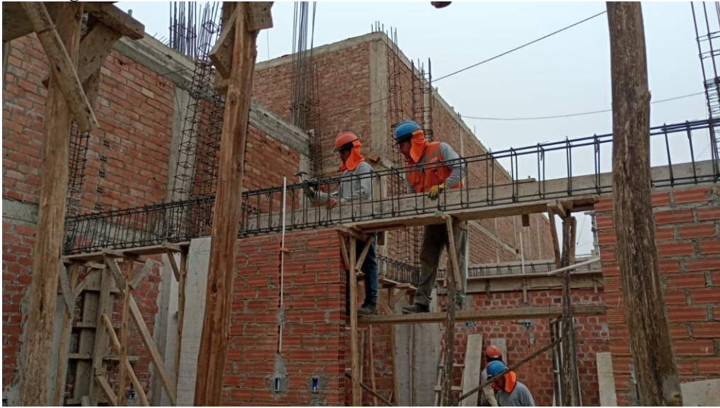
Figura 24 Armado de Viga
