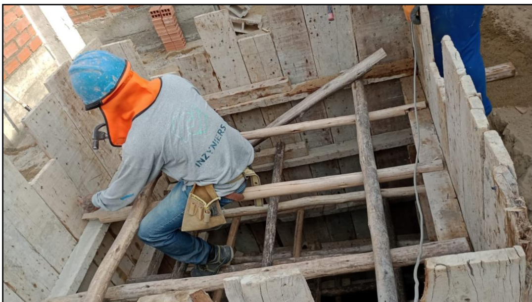
Figura 32 Encofrado de Cisterna
