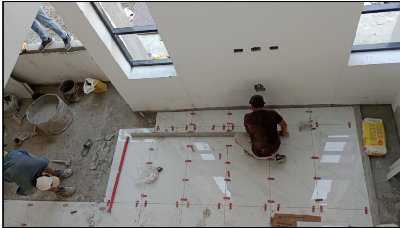
Figura 40 Enchapado de sala y comedor
