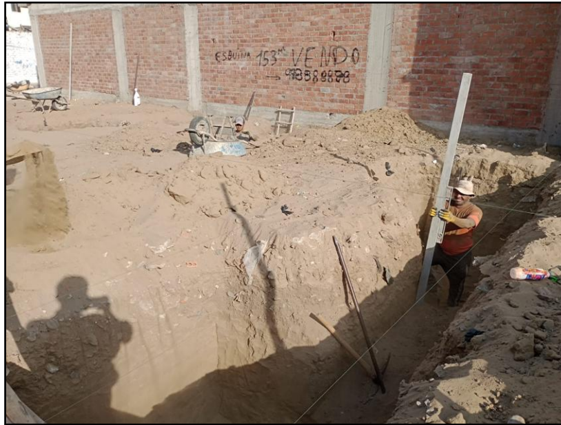
Figura 14 Trabajos de Excavaciones
