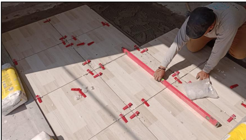
Figura 38 Nivelación de Enchapado
