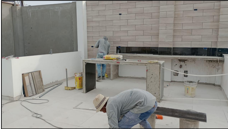
Figura 42 Enchapado de Mesada en Terraza
