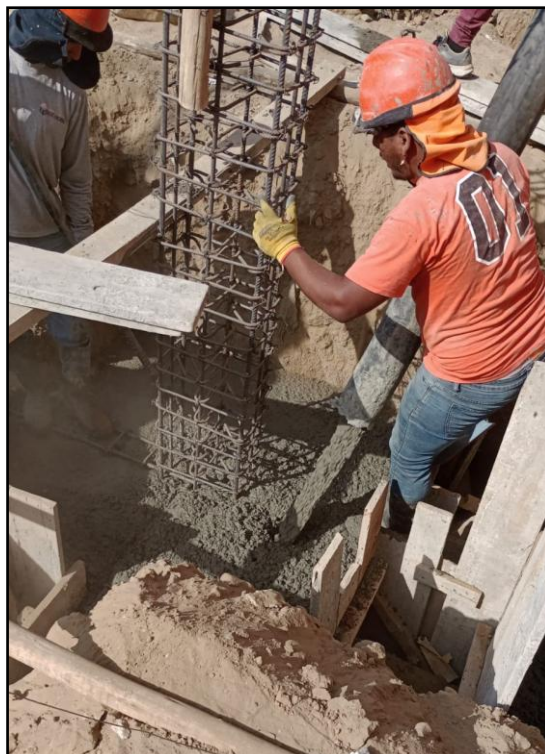
Figura 21 Vaciado de Zapatas y Vigas de Cimentación
