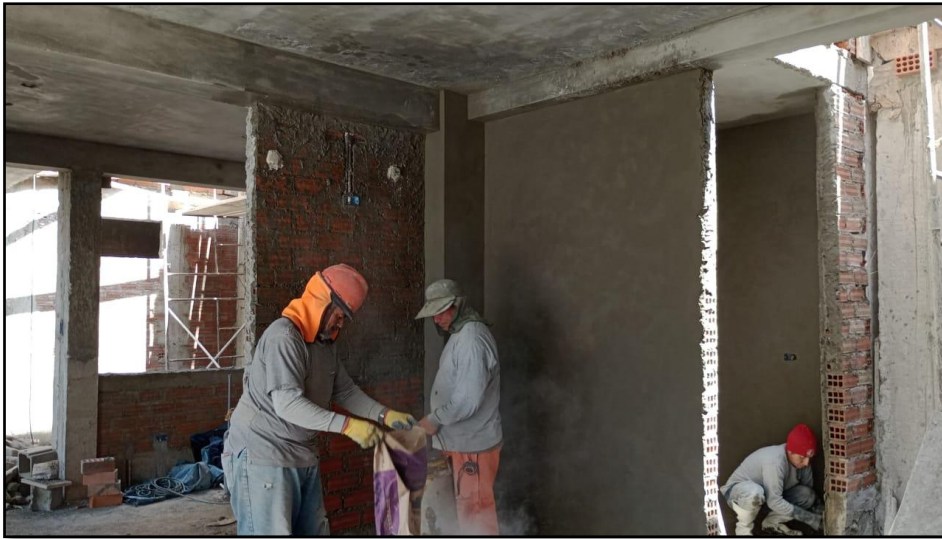
Figura 37 Control de Espesor de Tarrajeo
