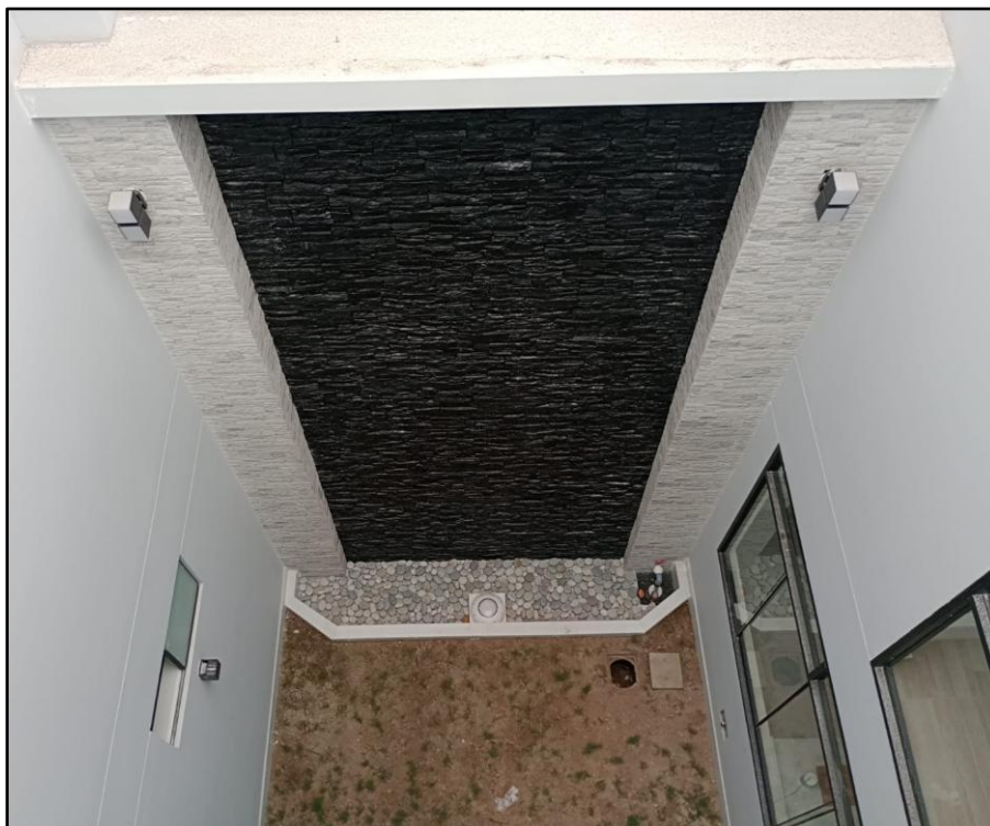
Figura 43 Enchapado Final de Muro Llorón
