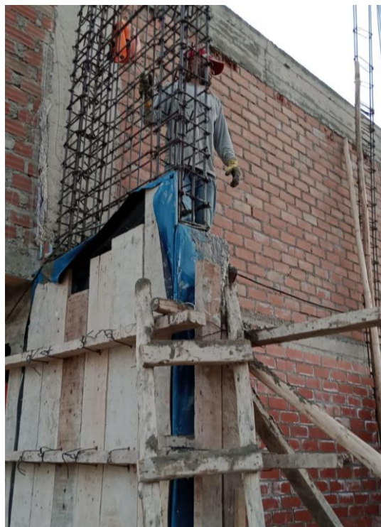
Figura 27 Armado de Columna en el Segundo Nivel
