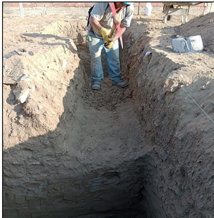
Figura 15 Trabajos de Perfilado de Secciones Excavadas
