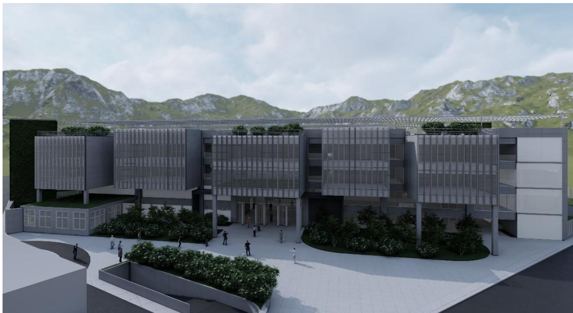
Figura 54: Acceso vehicular hacia sótano en Jr. La salud.
