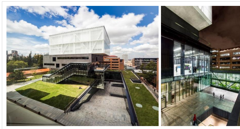
Figura 10: Vista de fachada este y pase a desnivel.
