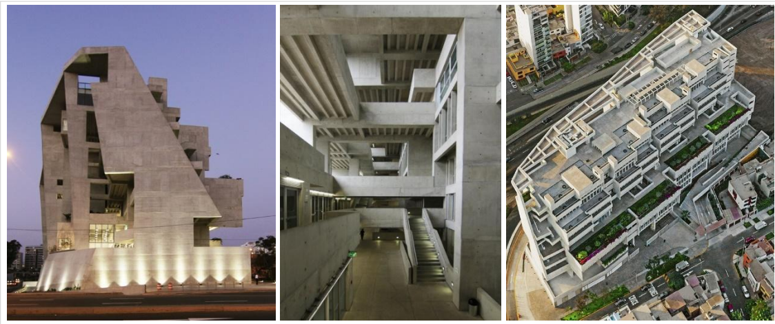
Figura 8: Vista fachada oeste, circulaciones interiores y vista de fachada escalonada.
