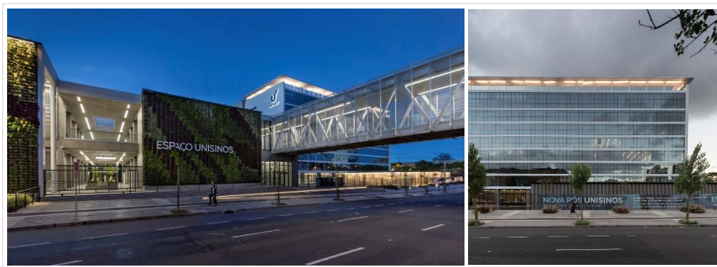
Figura 11: Vista de fachada Sur.
