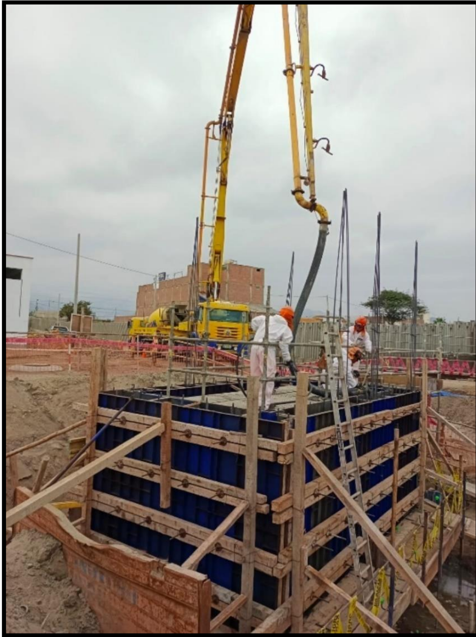
Figura 3.18 Llenado de muro 3er nivel
