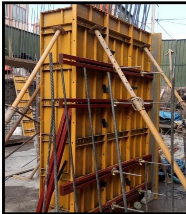
Figura 2.2 Apuntalamiento de encofrado metálico en columnas
