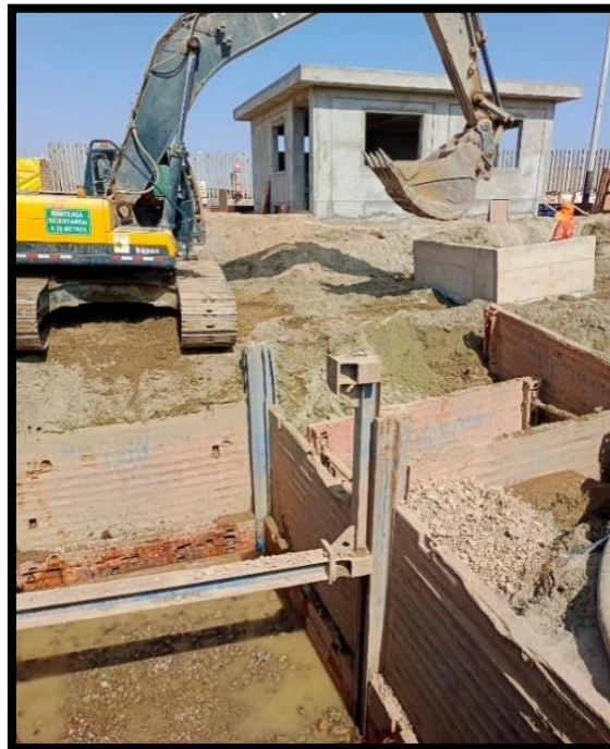
Figura 3.5 Colocación de Pilares
