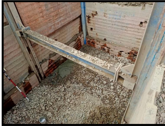
Figura 3.6 Colocación de planchas metálicas
