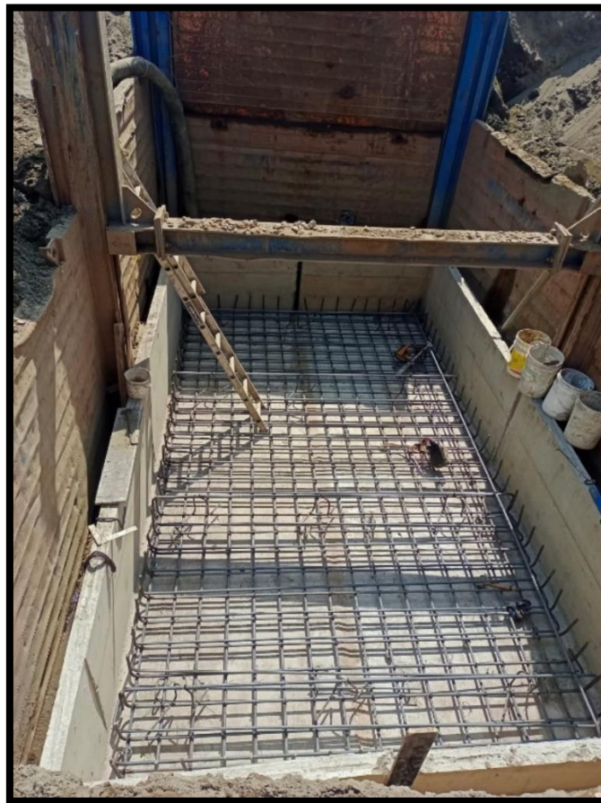
Figura 3.11 Finalización de colocación de solado prefabricado
