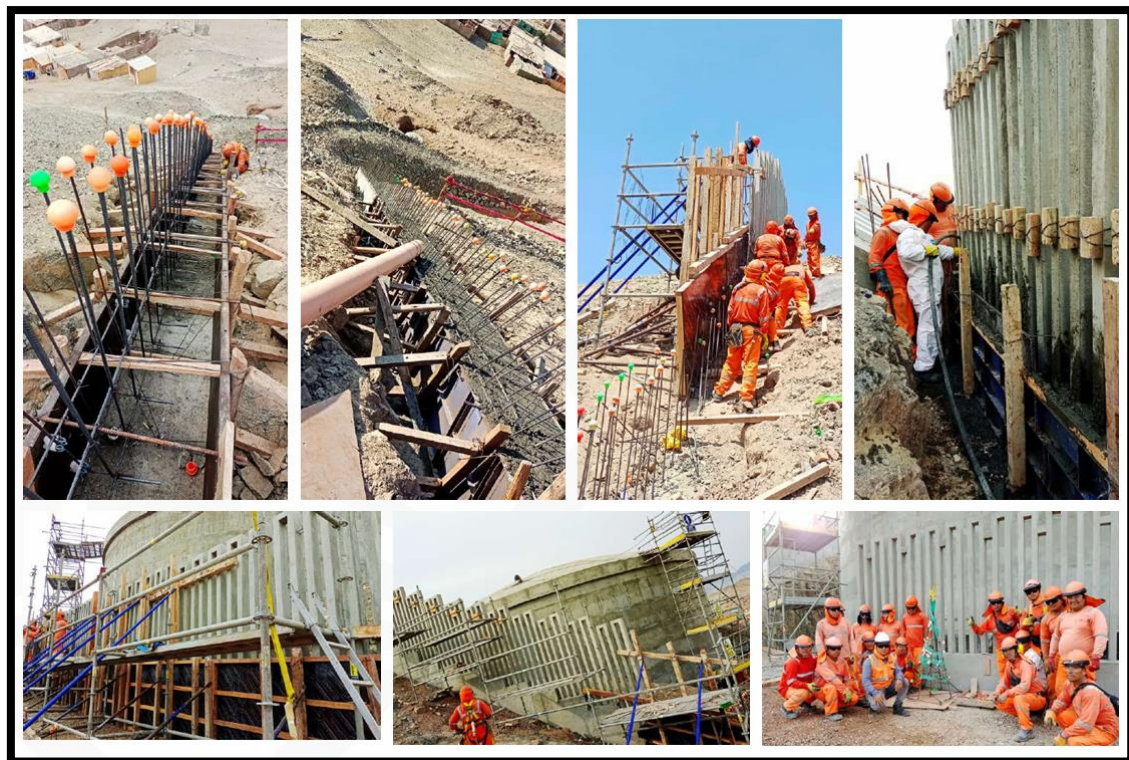
Figura 1.3 Construcción de reservorio apoyado de 1500m3 y cerco tipo uni.
