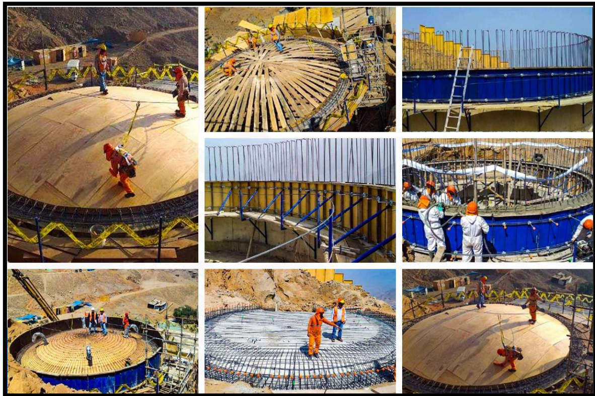
Figura 1.9 Construcción de Reservoirio elevado 1000m 3
