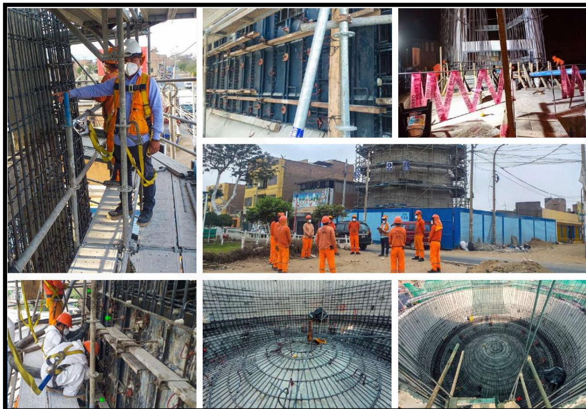
Figura 1.8 Construcción de Reservorio elevado 300m 3
