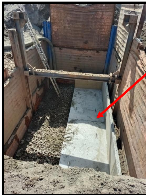
Figura 3.10 Instalación de solado prefabricado
