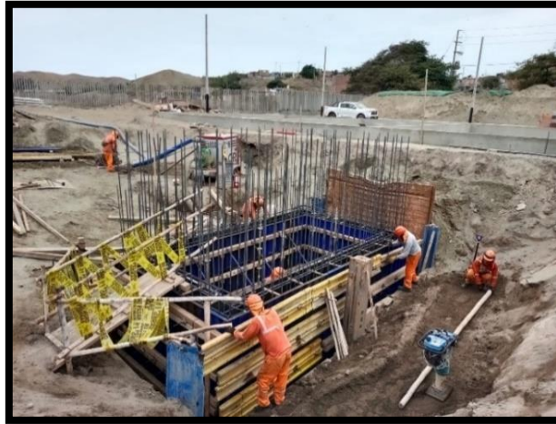
Figura 3.15 Encofrado cara externa
