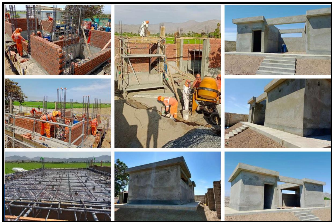
Figura 1.5 Construcción de Caseta de pozo PP-01
