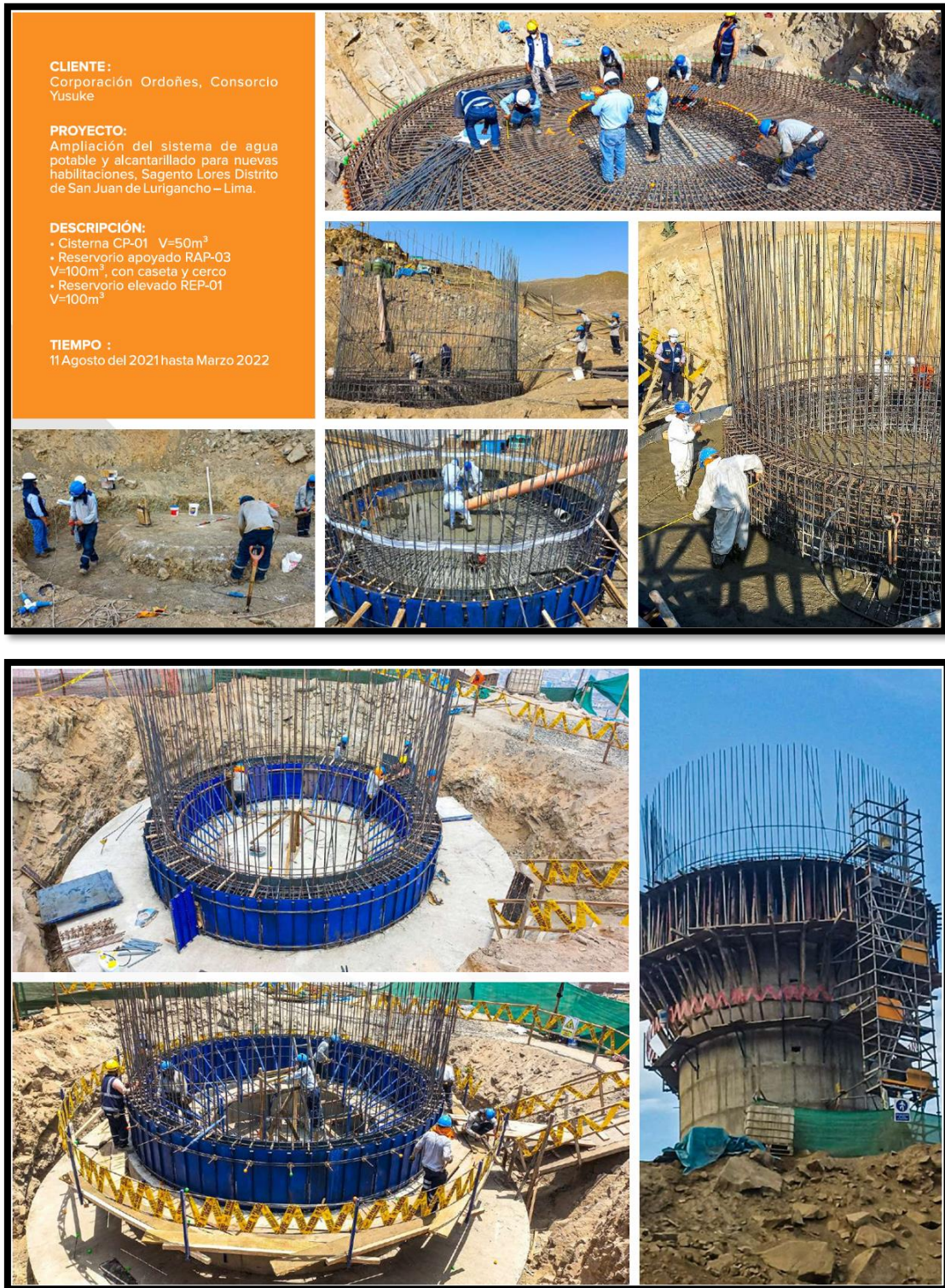
Figura 1.6 Construcción de Reservorio elevado 100m 3
