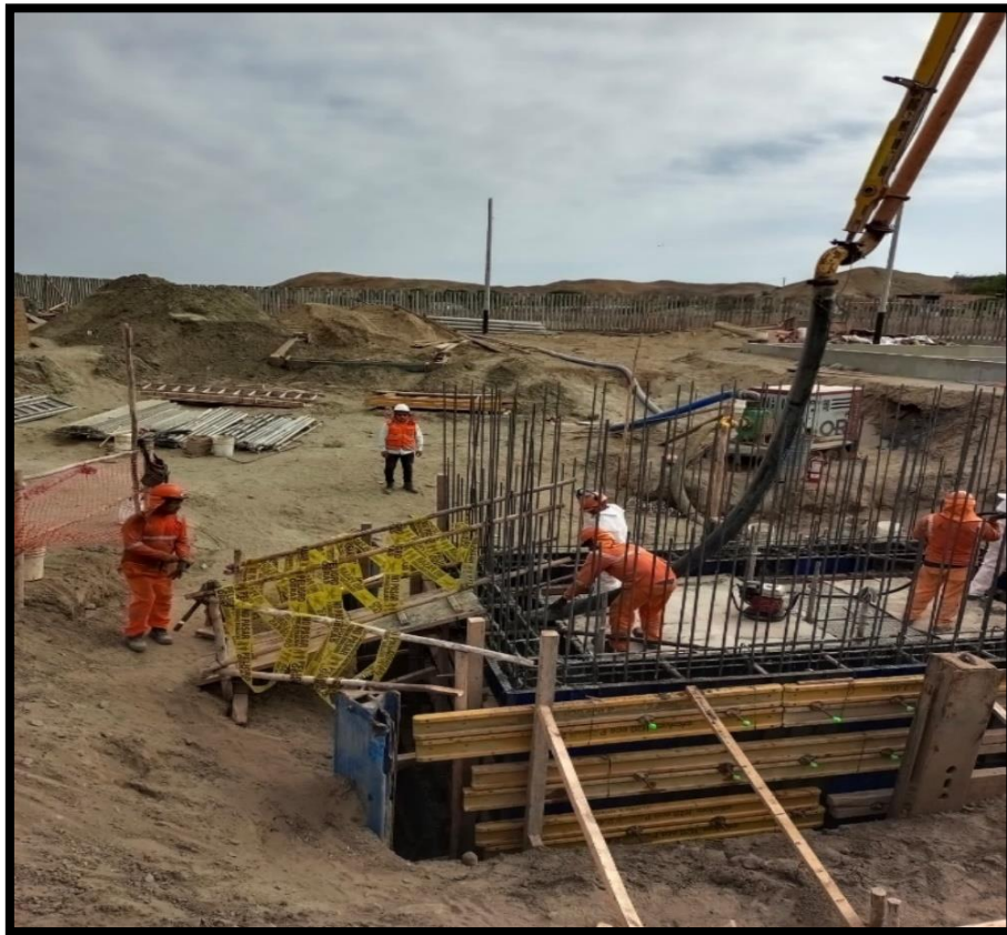
Figura 3.17 Llenado de muro - 2do nivel
