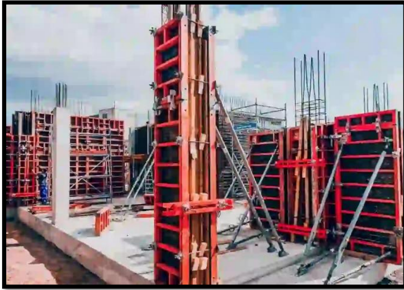
Figura 2.1 Encofrado metálico en columnas
