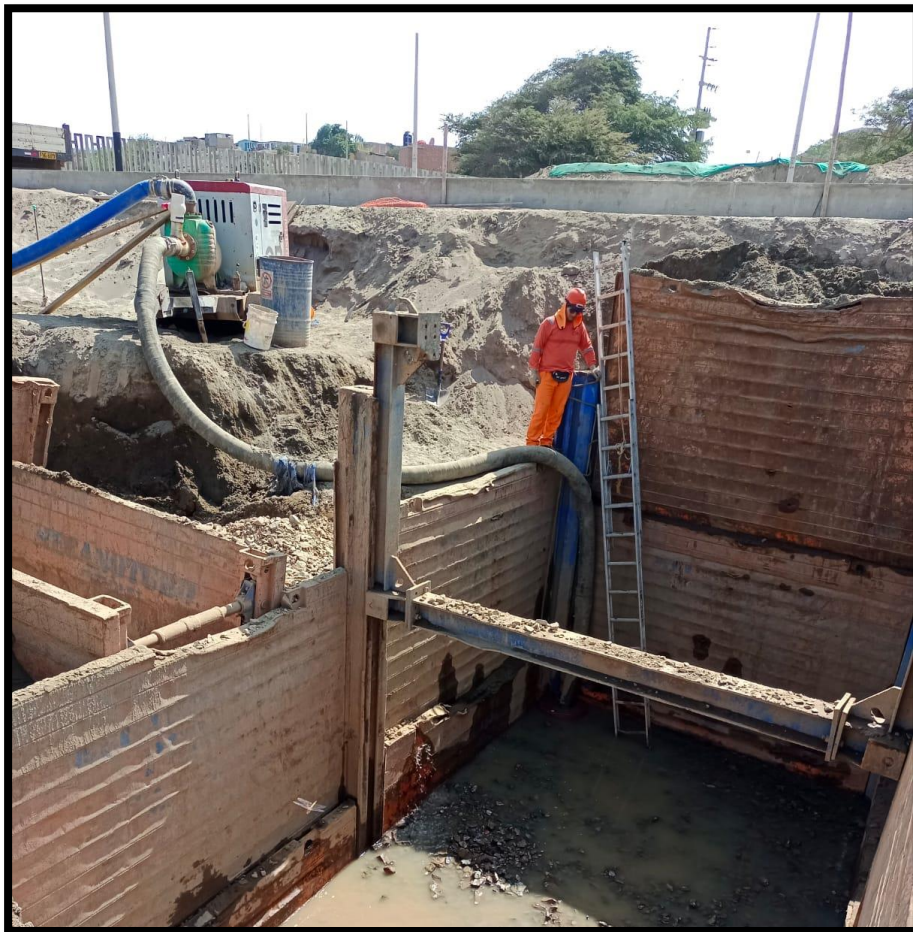
Figura 4.5 Instalación de elementos metálicos
