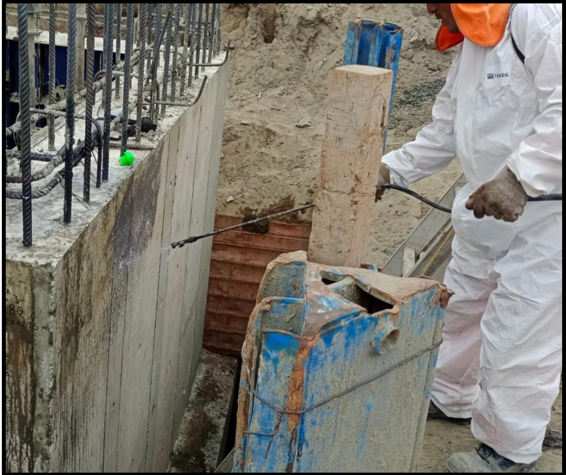
Figura 4.6 Curado de Muro cara vista
