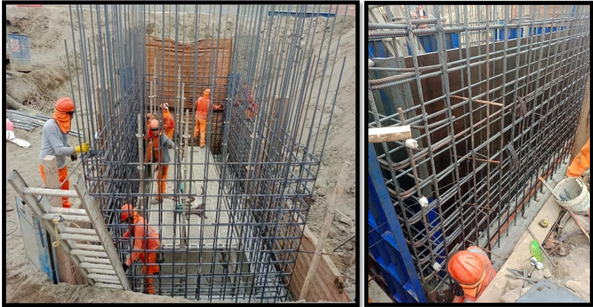
Figura 3.12 Enfierrado de muro de cisterna
