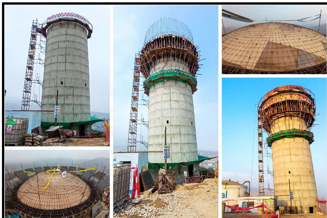
Figura 1.7 Construcción de Reservorio elevado 250m 3
