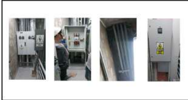
Figura 4 Trabajo de instalación de tableros.
