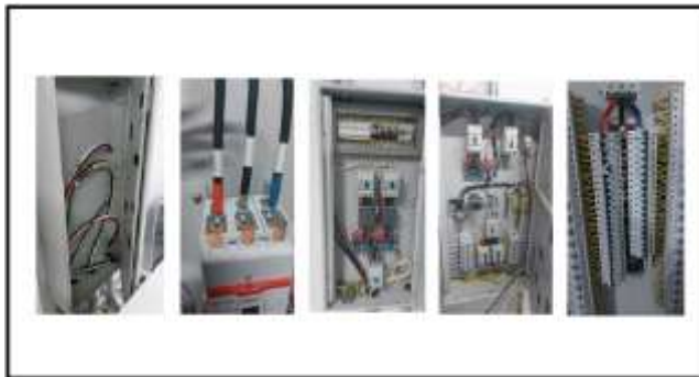
Figura 5 Instalación de tablero en cuartos eléctricos
