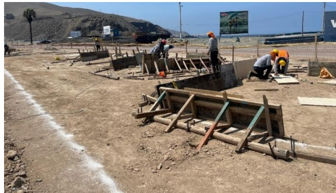
Encofrado de bancas con forma de letra Santa Rosa
