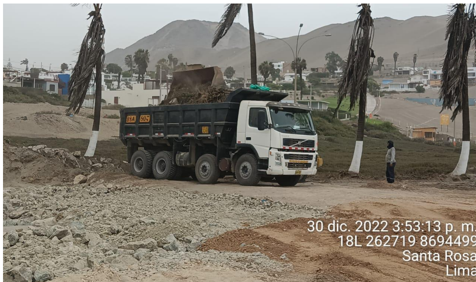
Transporte de material excedente al botadero
