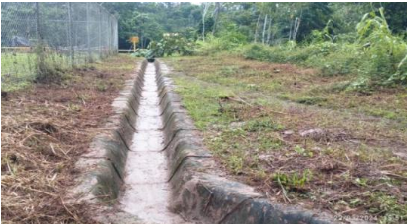
Drenaje Perimetral Norte
