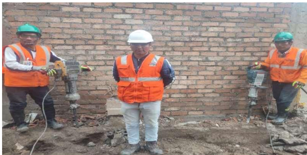
Demolición de cimentaciones con rotomartillo
