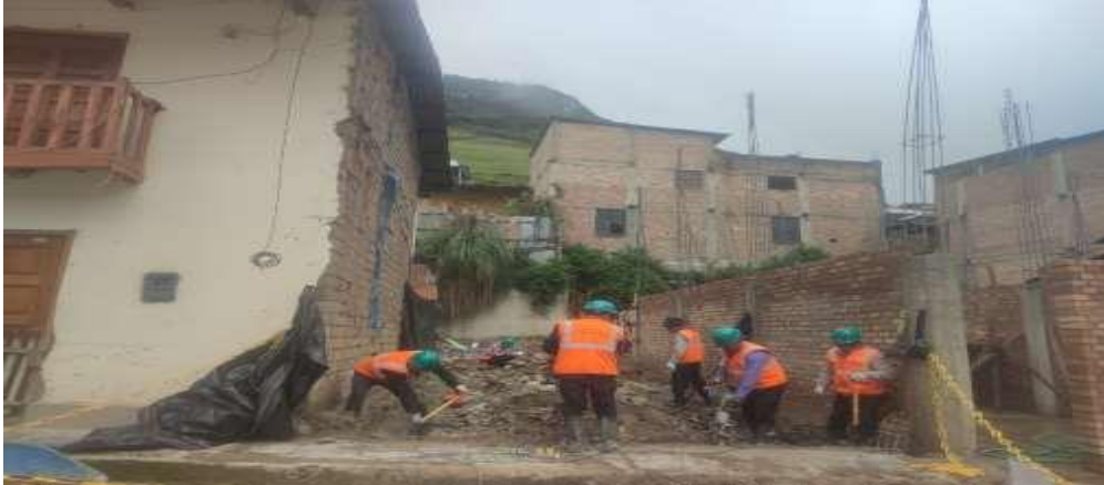
Demolición de sobrecimientos y zapatas con rotomartillo
