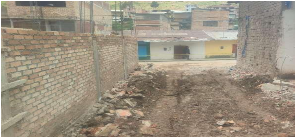
Nivelación de terreno
