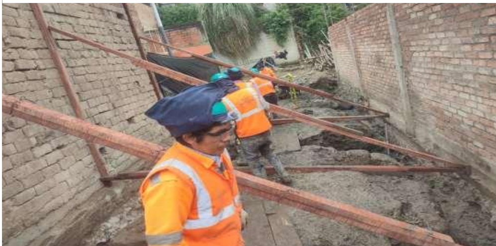
Apuntalamiento de estructuras existentes colindantes a los trabajos de excavaciones.
