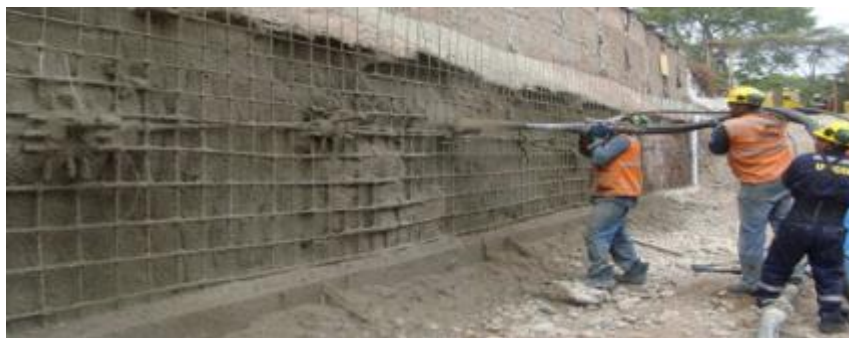
Figura N.º 2: Shotcrete vía húmeda en muros pantalla (UNICON, 2014).
