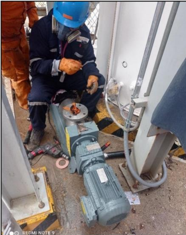
Montaje de bomba de impulsión
