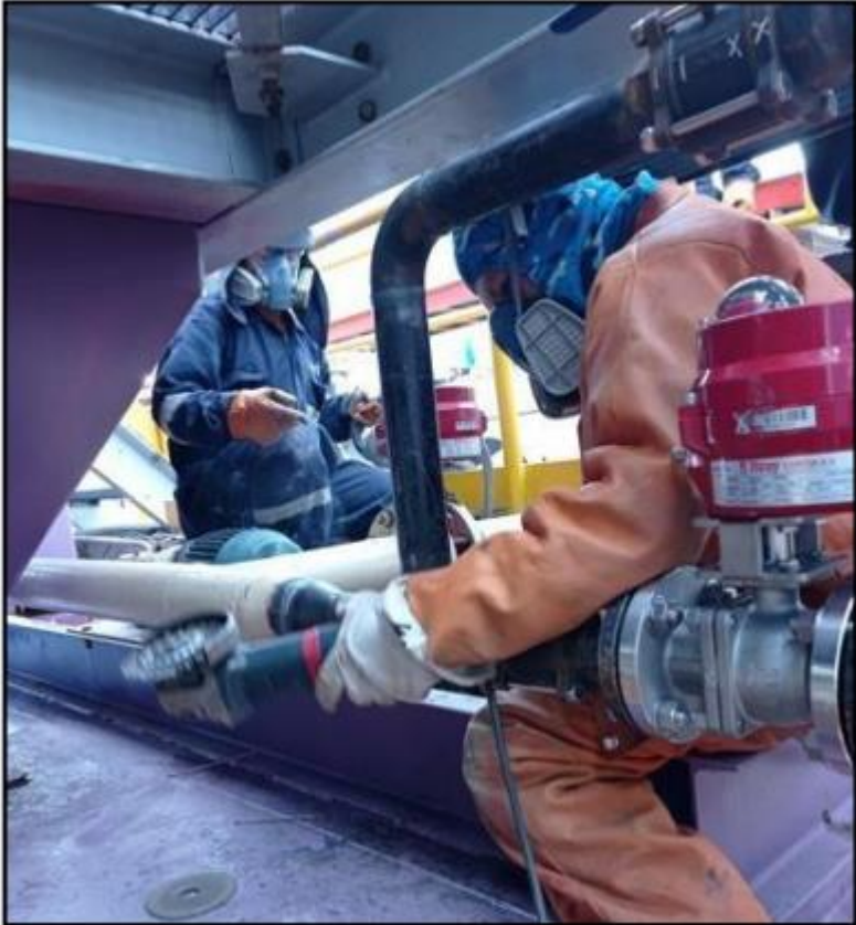
Montaje de válvula de control para barren de servicio
