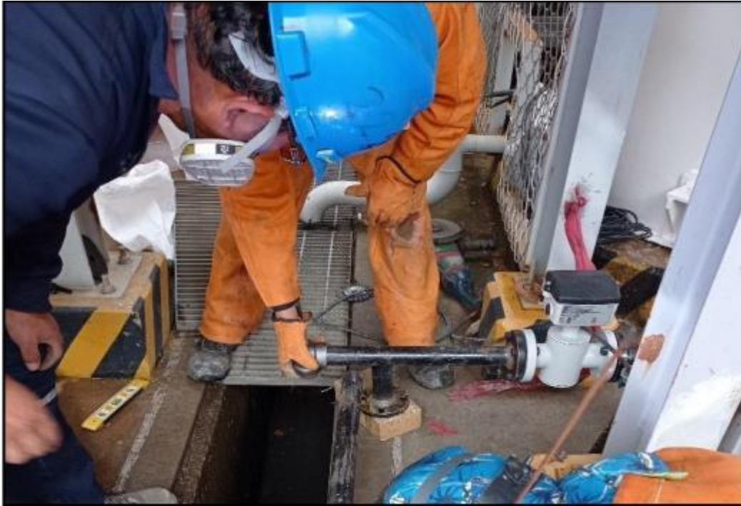
Montaje de tuberías casing para líneas de impulsión
