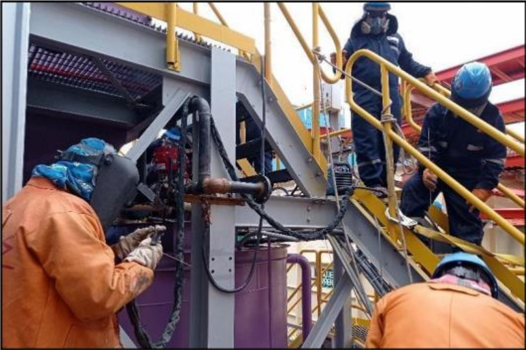
Montaje de válvula de control para barren de servicio
