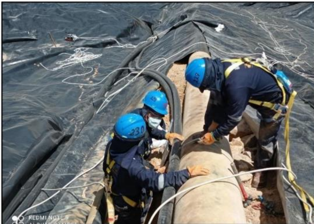
Montaje de tuberías casing para líneas de impulsión
