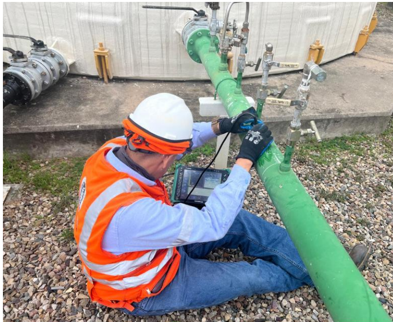
Inspección Phased Array
