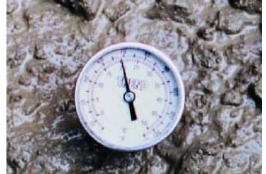
Figure 19: Imagen referencial de medición de temperatura del concreto fresco
