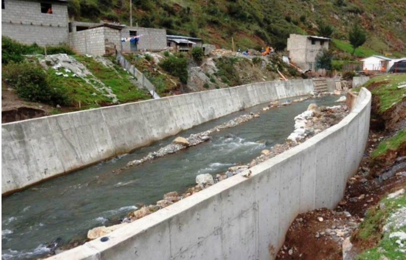
Figura 11. Defensa ribereña de muro de concreto
