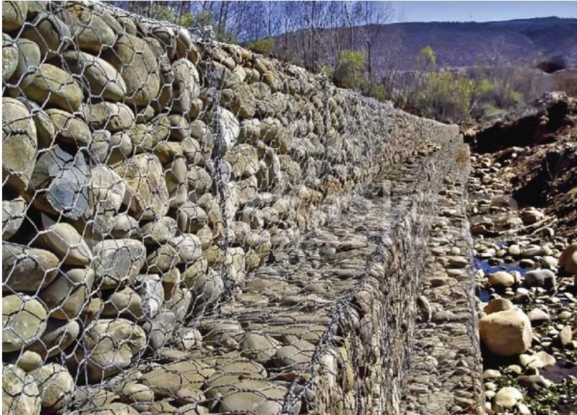
Figura 12. Defensa ribereña con muro de gaviones
